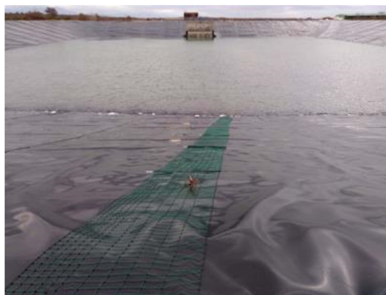
Figure 11 : Exemple de grillage de sécurité pour la remontée d'animaux
