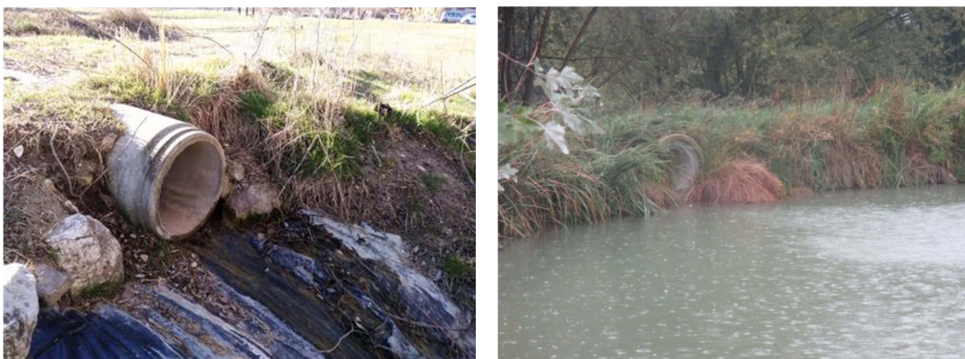
Figure 13 : la vidange actuelle côté aval et côté amont
