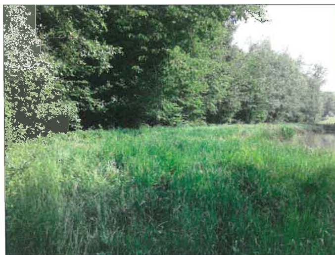
Vues de la digue
