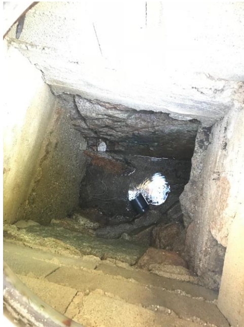
Figure 7 : Ouvrage de captage de la source de Smargine haute
