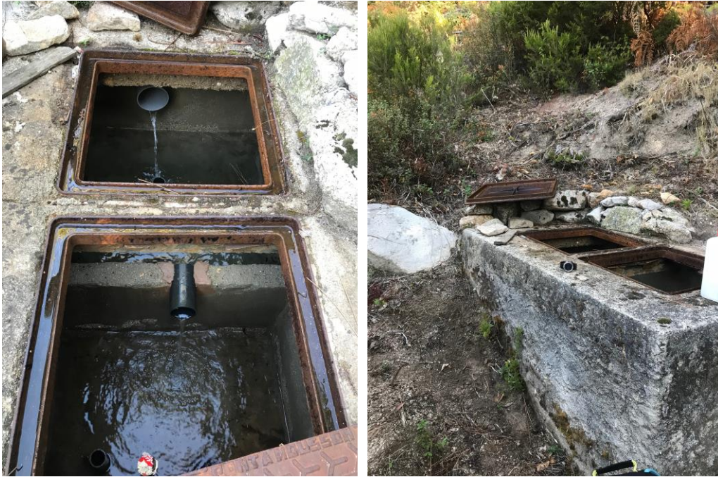
Figure 8 : Ouvrage de collecte de la source de Smargine haute
