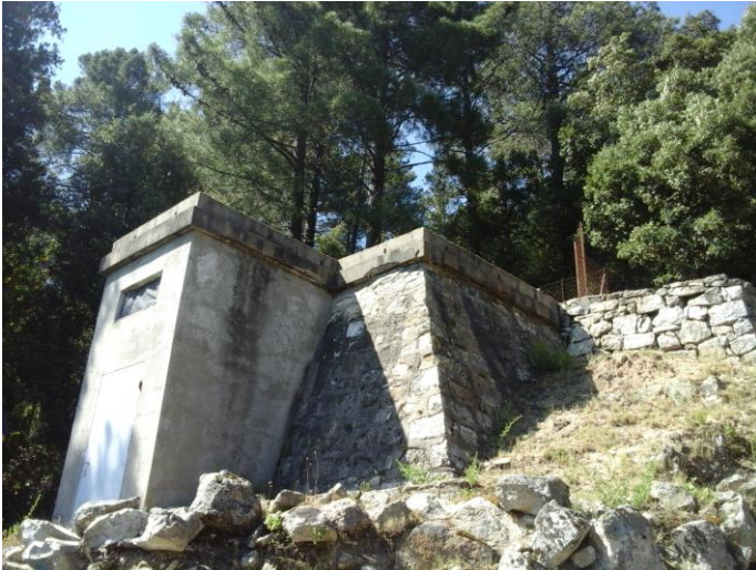
Figure 14 : Vue d'ensemble du réservoir de Nivale
