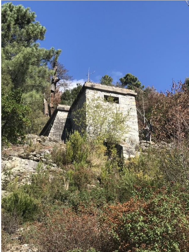
Figure 12 : Vue d'ensemble du réservoir de Chiappa
