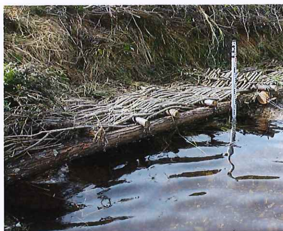
Exemple de cache en berge végétalisée par boutures et ensemencement (© V. Peyronnet, 2007-2012)
