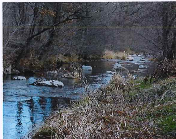
Zone intermédiaire après pose des blocs
