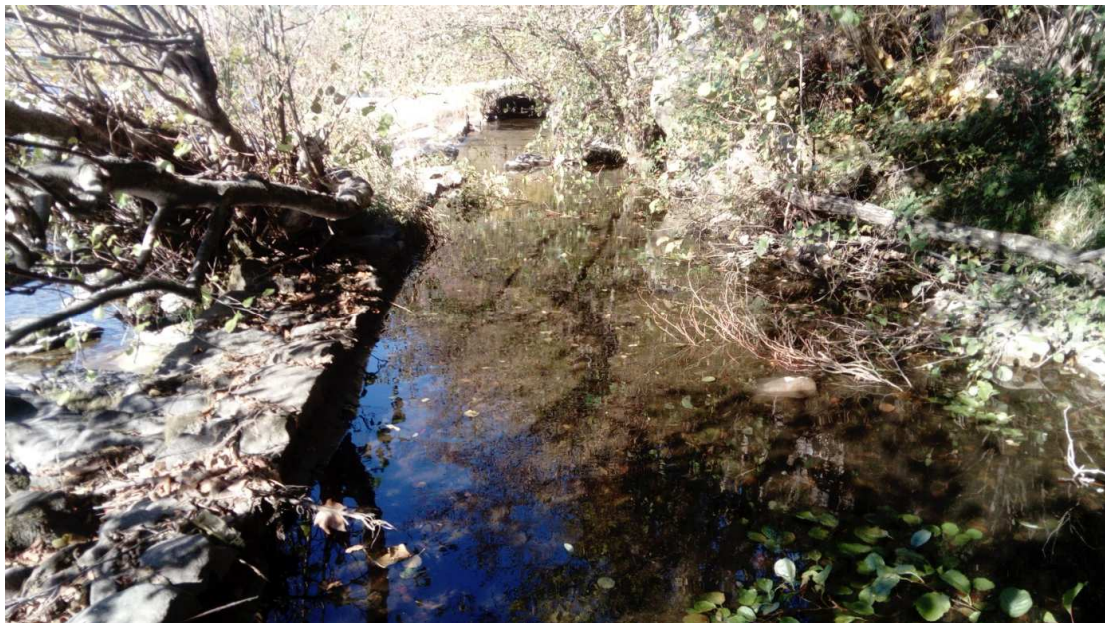
Figure 13 : Ancienne prise d'eau, en rive gauche de l'Ardèche (vue depuis l'aval)
