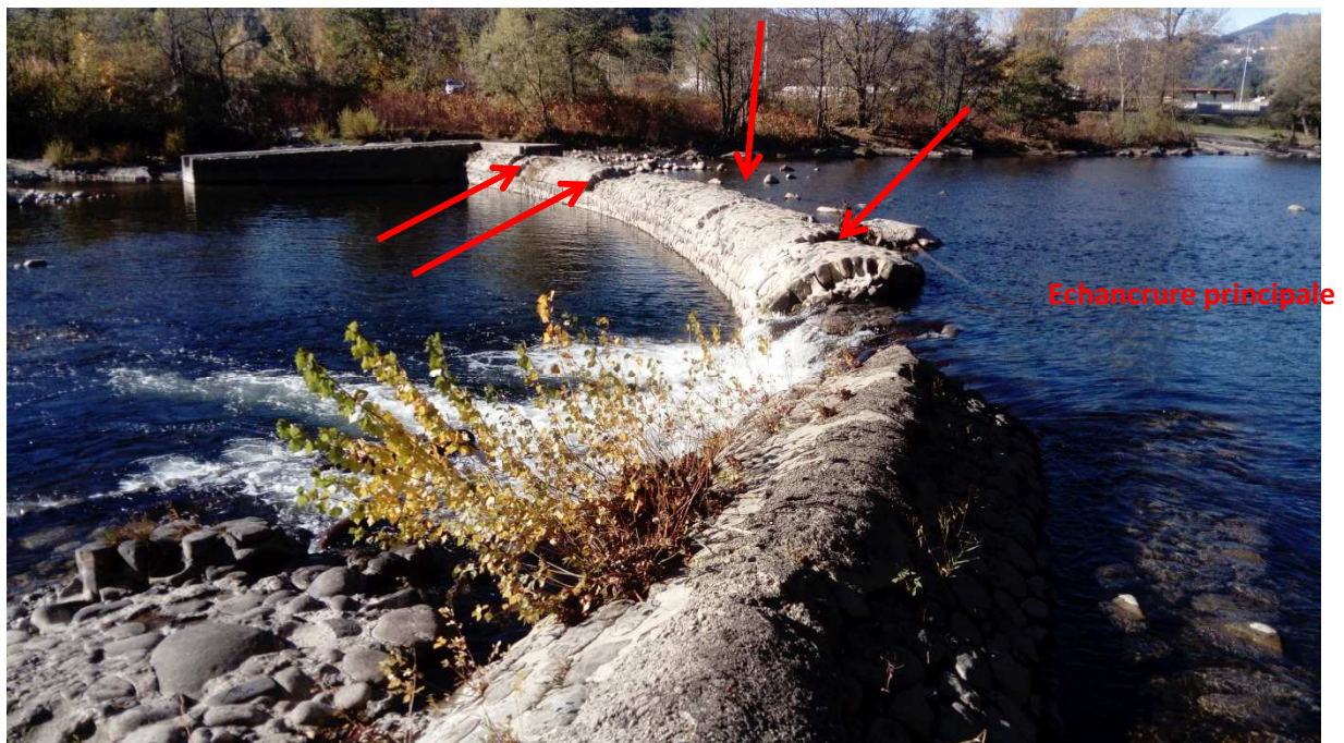
Figure 11 : Localisation des multiples échancrures dans la crête du seuil
