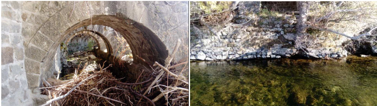
Figure 18 : Ancien canal et mur de soutènement de la route
