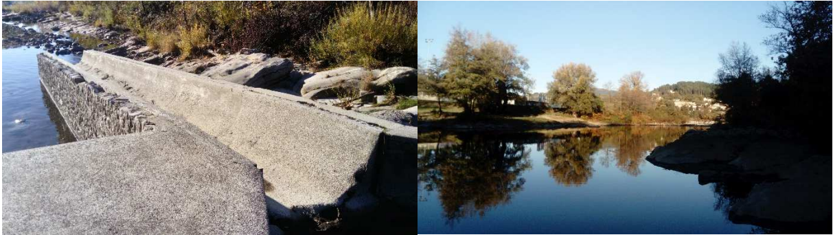
Figure 26 : Photographies de la passe à canoë et du plan d'eau en amont du seuil
