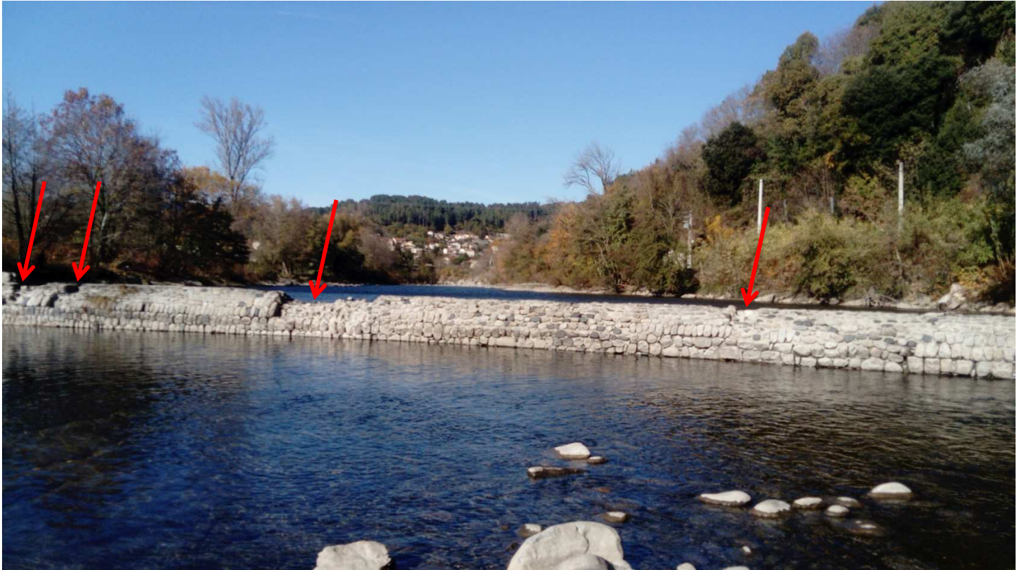
Figure 12 : Localisation des multiples échancrures dans la crête du seuil
