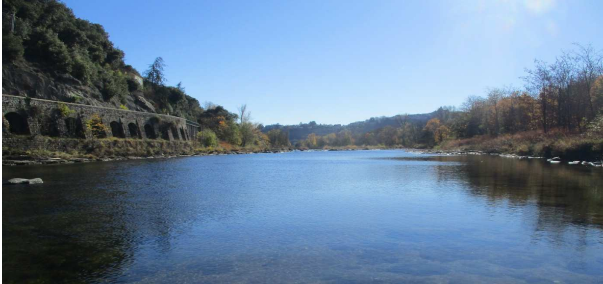
Figure 19 : Photographie du plan d'eau naturel en aval du seuil et en aval du banc alluvial actuel
