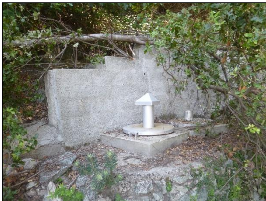
Photo 9 : Regards de collecte / décantation et regard de départ de la prise d'eau de FIUMINALE (TPAe, 15/06/2017)
