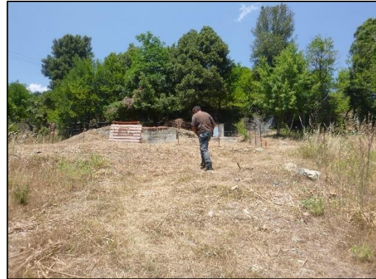
Photo 31 : Clôture autour du réservoir de POGGIOLO (TPAe, 15/06/2017)
