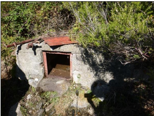
Photo 2 : Captage de PADULE, trappe d'accès (TPAe, 21/09/2017)
