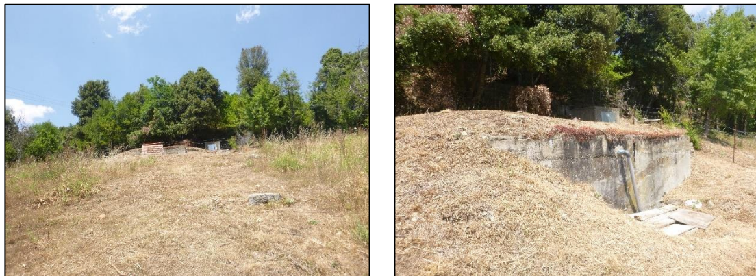
Photo 27 : Réservoir de POGGIOLO, vue générale (TPAe, 15/06/2017)
