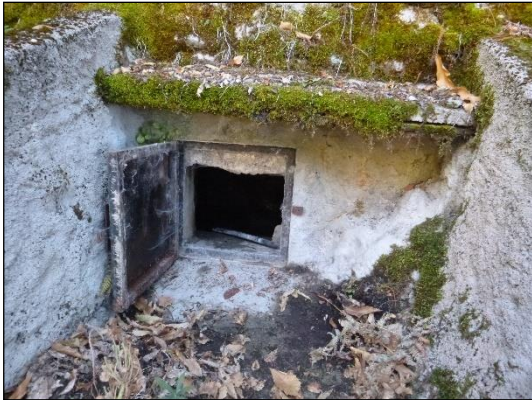
Photo 7 : Trappe de visite de la cabine de collecte (TPAe, 21/09/2017)
