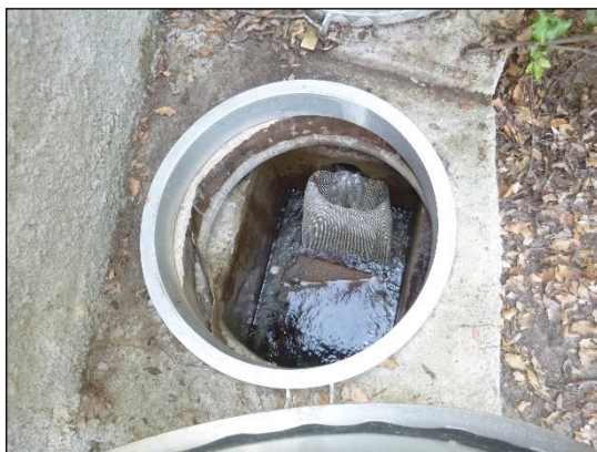
Photo 12 : Regard de départ vers le réservoir de FIUMINALE (TPAe, 15/06/2017)
