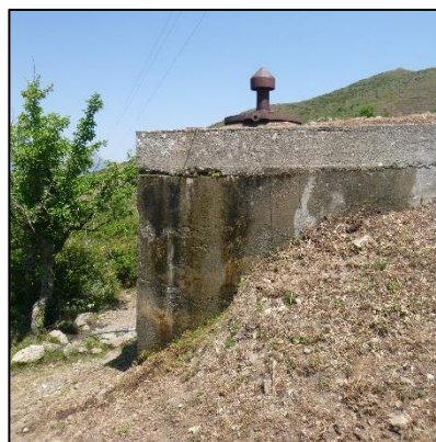
Photo 22 : Réservoir 2, vue générale, fissures extérieures et suintements (TPAe, 15/06/2017)
