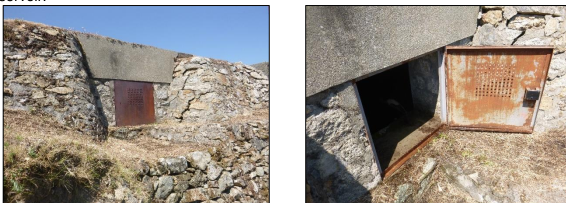
Photo 19 : Trappe d'accès au réservoir 1 (TPAe, 15/06/2017)
