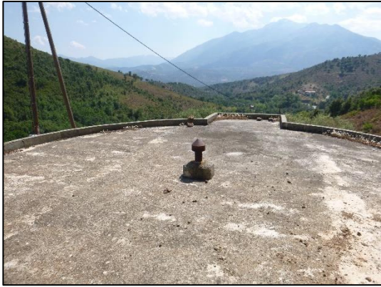
Photo 38 : Cheminée d'aération du réservoir de FIUMINALE (TPAe, 15/06/2017)
