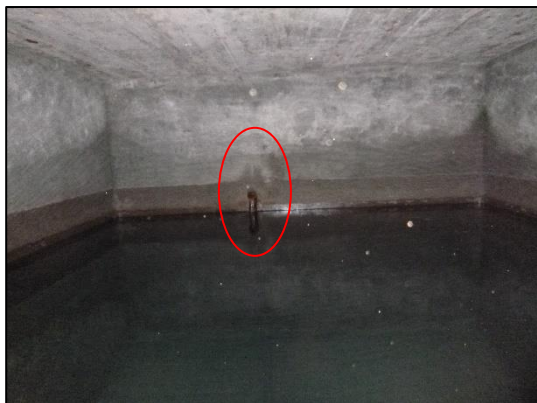
Photo 33 : Intérieur du réservoir de PIEDIVALDO avec la conduite d'adduction (TPAe, 15/06/2017)
