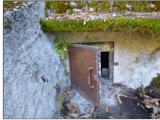
Photo 7 : Trappe de visite de la cabine de collecte (TPAe, 21/09/2017)
