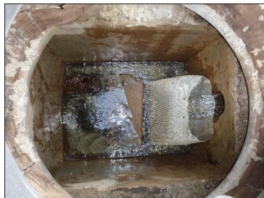
Photo 12 : Regard de départ vers le réservoir de FIUMINALE (TPAe, 15/06/2017)
