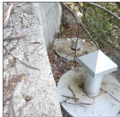
Photo 9 : Regards de collecte / décantation et regard de départ de la prise d'eau de FIUMINALE (TPAe, 15/06/2017)
