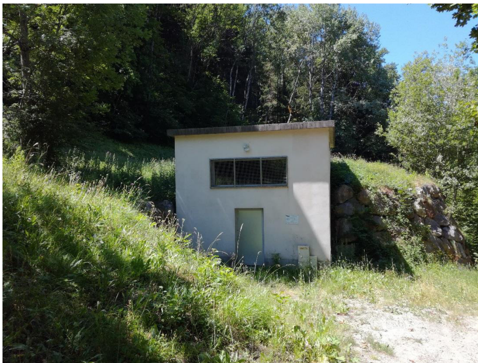
Fig. 3-d : Vue de l'entrée du réservoir de Sangot (500 m 3 ) – juin 2018.
