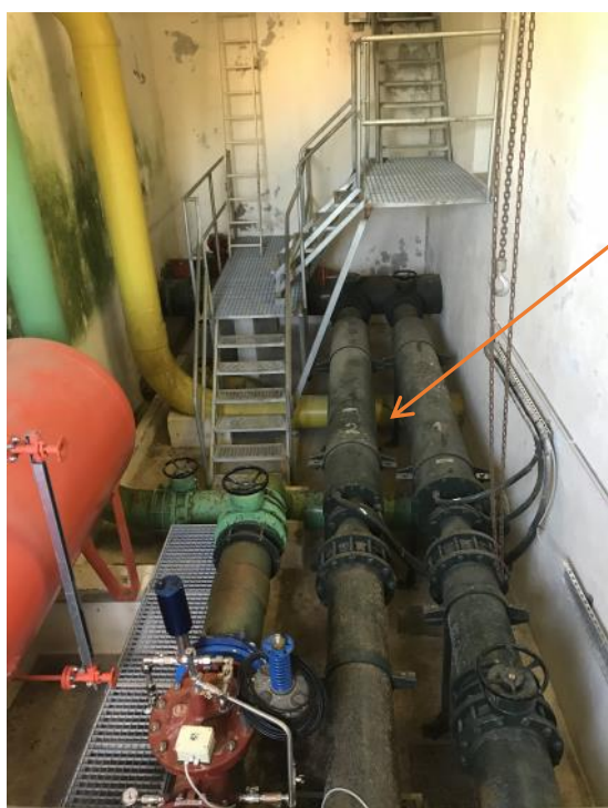
Figure 16 : Surpresseur du réservoir du SEREN
