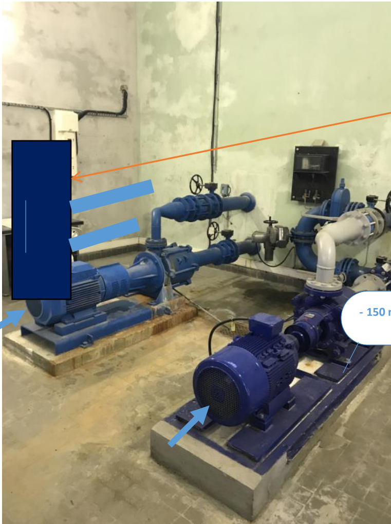
Figure 24 : Local de pompage existant (surpresseur Malvan) et projet de 3 ième pompe de 240 m 3 /h
