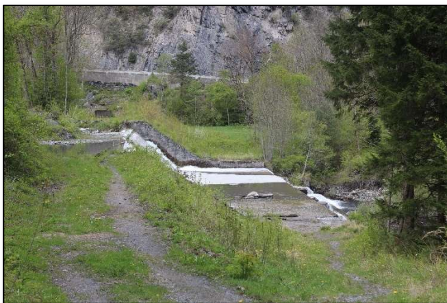
Figure 38 : Barrage n°1 de la Poyat (Hydrétudes, 05/2016)
