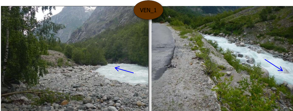
Figure 67 : Cône de déjection de la combe de la Pierre Blanche. On remarque une végétalisation commençant à fixer le cône sur les parties les moins actives lors des événements Basse Fréquence Haute Magnitude*.
