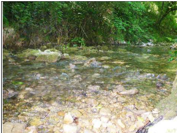
▲ Vue d'un radier à mi-parcours
