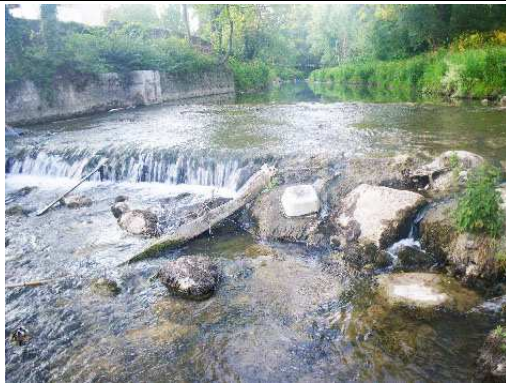
▲ Vue vers l'amont depuis la limite aval
