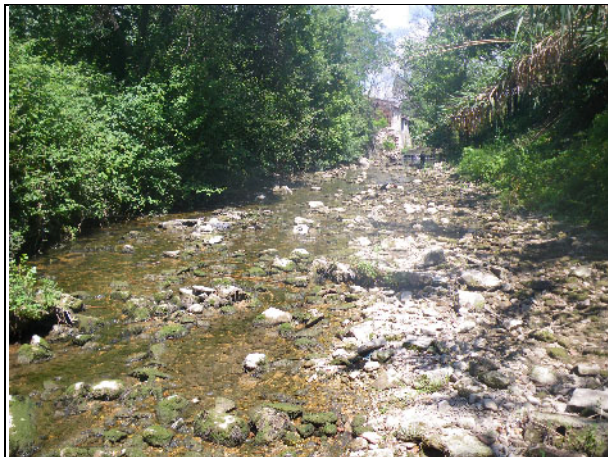
▲ Vue vers l'amont depuis la limite aval
