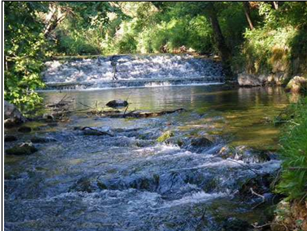
▲ Vue du radier amont.
