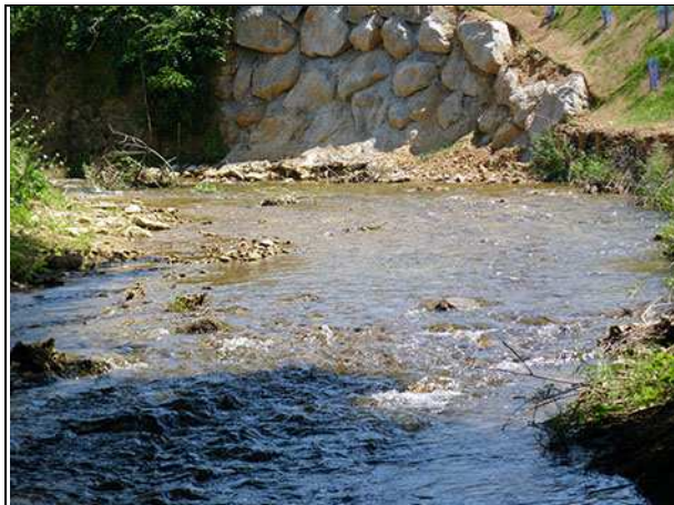
▲ Vue vers l'amont (radier amont).
