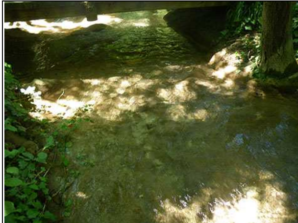
▲ Vue du radier aval.
