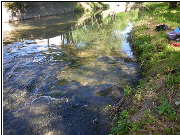
▲ Vue du radier aval.
