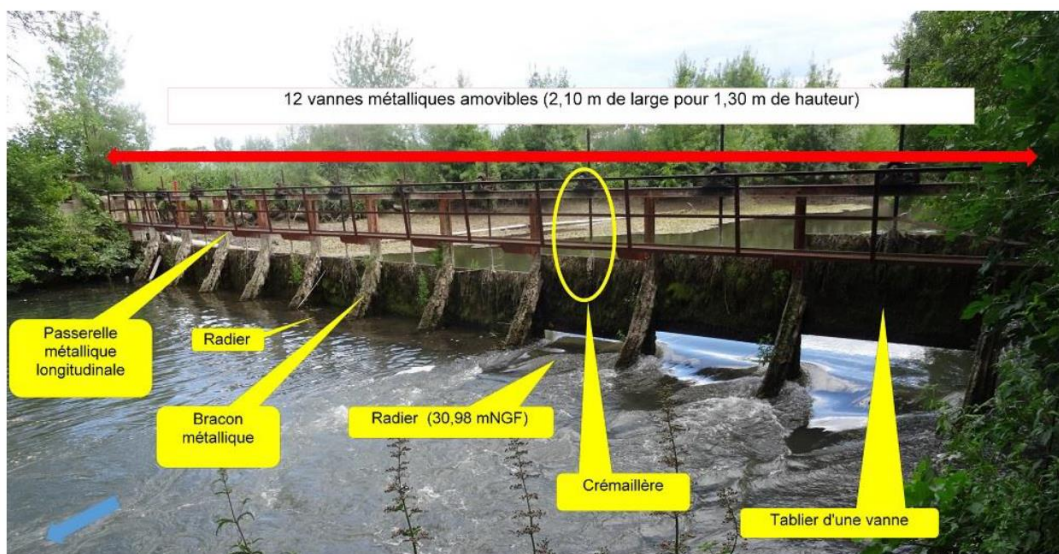
Figure 4 : Description du barrage et des vannages (Source Symbiose)
