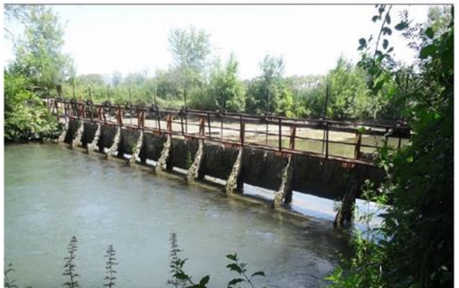
Vue aval du barrage, vannes levées
