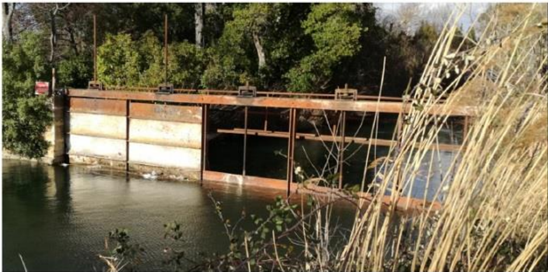
Vue amont des vannes du canal usinier
