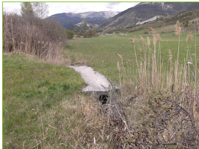
Passage busé situé à l'aval de la zone humide © L. Granato | CEN PACA
