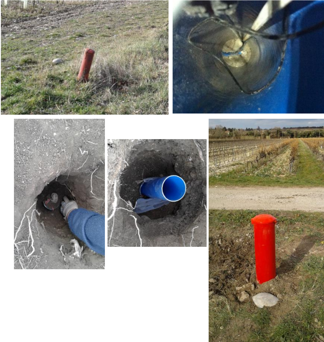
Illustration 6 : Réparation de l'ouvrage 08905X4000/PZ de Tulette (26)
