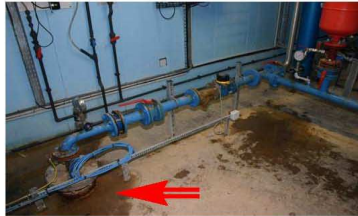
Le forage. Un piquage sera installé au cours du premier semestre 2008.
