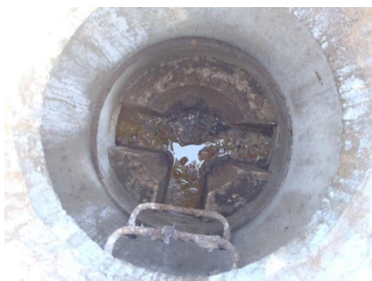
Dépôts – Regard n°1001 – Réseau eaux usées
