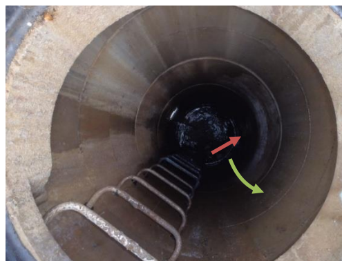
Intérieur DO5 – Amont PR du Stade
