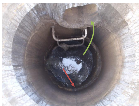
Intérieur DO7 – Amont PR Grande Gorge
