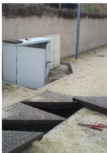
Extérieur PR9 – Chapois – Eaux usées
