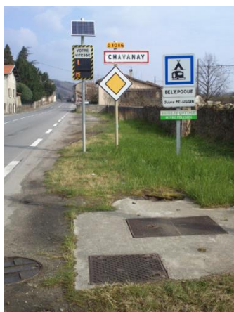
Extérieur PR8 - Grande Gorge – Eaux usées
