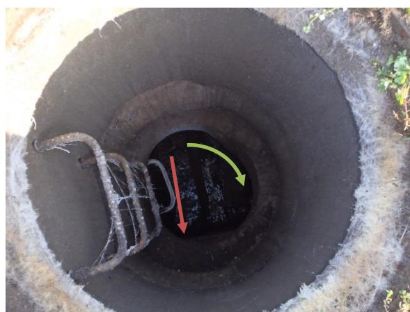
Intérieur DO6 – Rue du Chirat / Square du 11 Novembre
