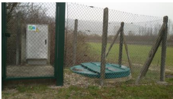
Vue extérieure – PR Vernat
