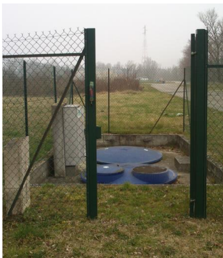
Vue extérieure – PR Verlieu
