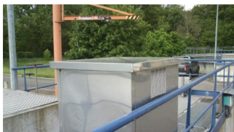
Préleveur en sortie de station
