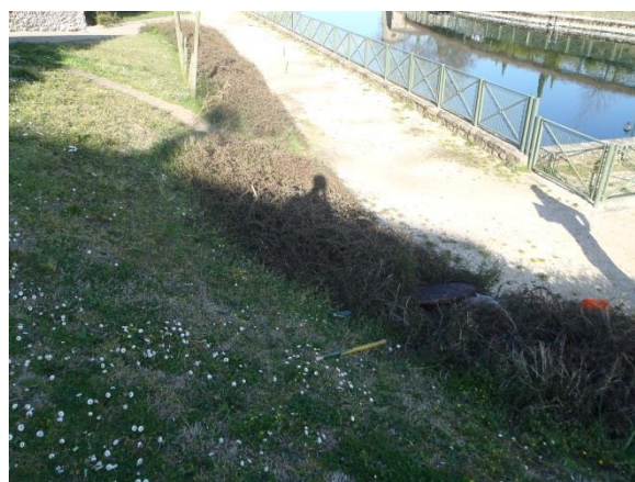
Cadre non scellé – Regard n°664 – Réseau eaux usées – Plan d'eau
