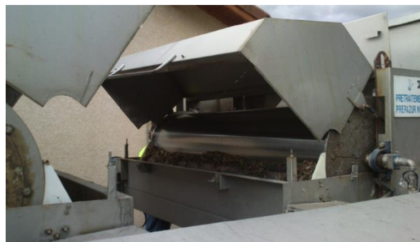
Prétraitements – Filtres à tambour
