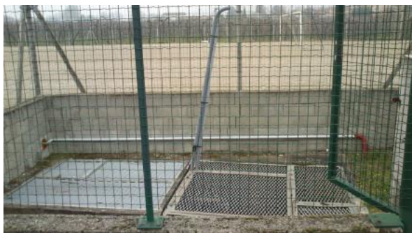
Vue extérieure – PR Stade
