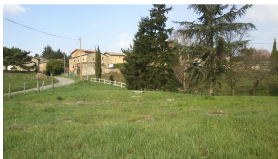
Fosse toutes eaux et filtre à sable du Triolet
