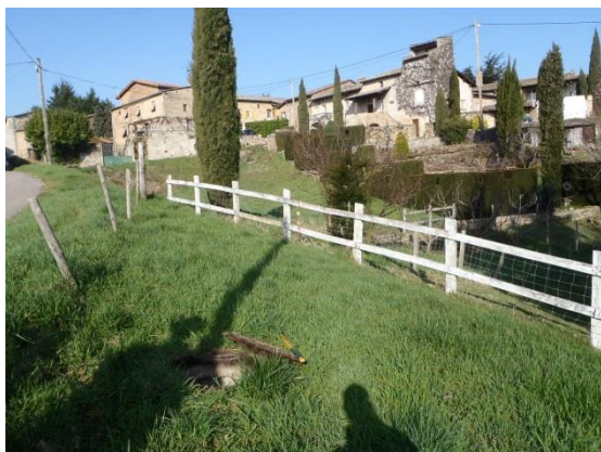
Extérieur DO8 – Amont STEP
