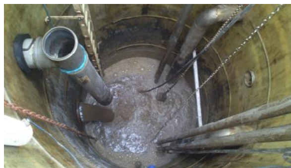
Vue intérieure – PR Vernat
