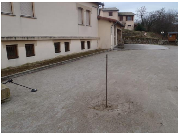
Regard enterré – Regard n°82 – Place du Belvédère – Réseau eaux usées
