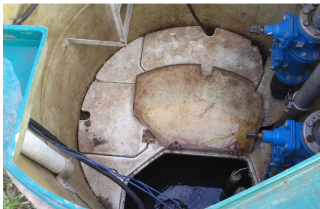
Vue intérieure – PR La Priverie / Chauramond
