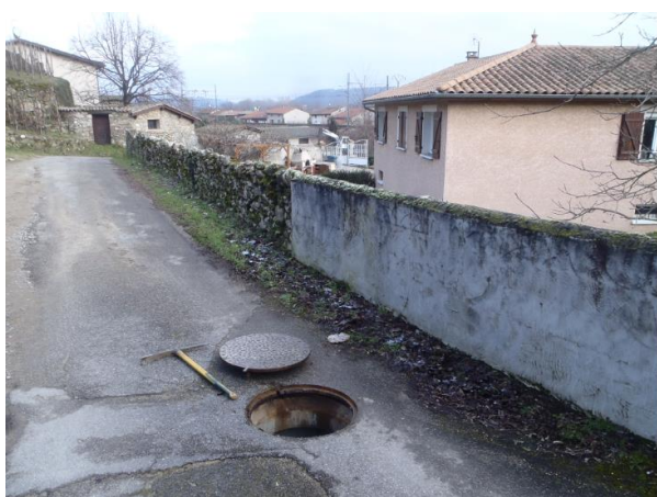
Extérieur DO3 – Route d'Annonay Carrefour
