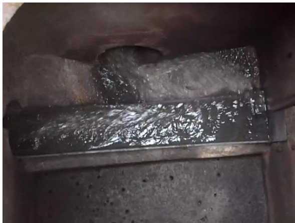
DO2 en fonctionnement par temps sec – Place du Belvédère
