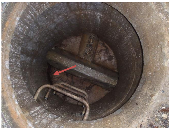
Racines – Regard n°61 – Rue Haute - Réseau eaux usées
