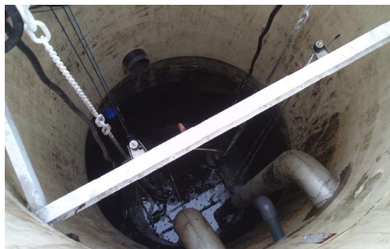
Vue intérieure – PR Jassoux pluvial
