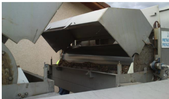
Prétraitements – Filtres à tambour
