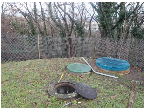
Extérieur DO1 – Amont PR La Priverie / Chauramond
