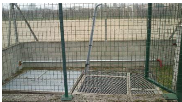
Vue extérieure – PR Stade
