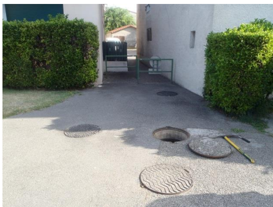
Extérieur DO1 – Ruelle des Terreaux
