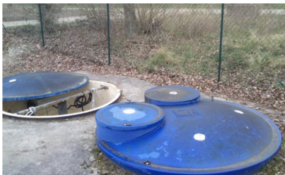
Vue extérieure – PR Jassoux pluvial
