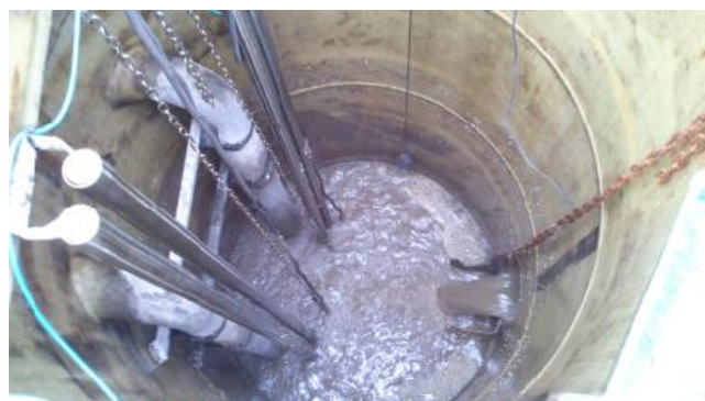
Vue intérieure – PR Jassoux Aval
