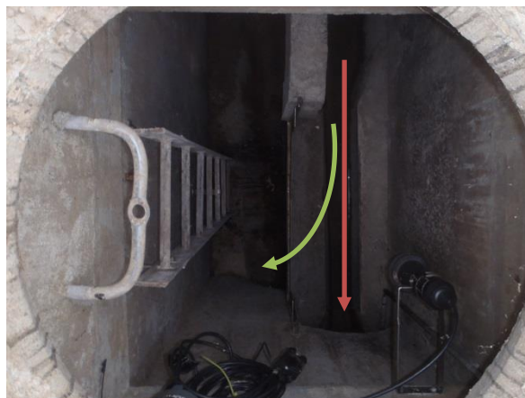
Intérieur DO2 – Ruelle des Terreaux
