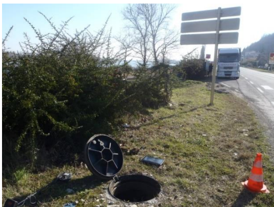
Vérin - Extérieur DO2 Quai du Rhône – Le Bourg
