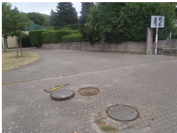
Extérieur DO2 – Ruelle des Terreaux
