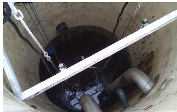
Vue intérieure – PR Jassoux pluvial
