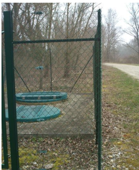
Vue extérieure – PR Jassoux Aval
