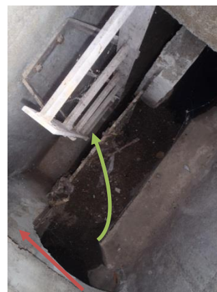
Intérieur DO1 – Ruelle des Terreaux
