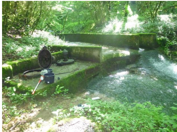
Figure 2 : Captage Darosa à Villebois avec canne de prélèvement (07/06/2016)
