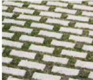
Pavage en béton avec ouvertures de drainage
