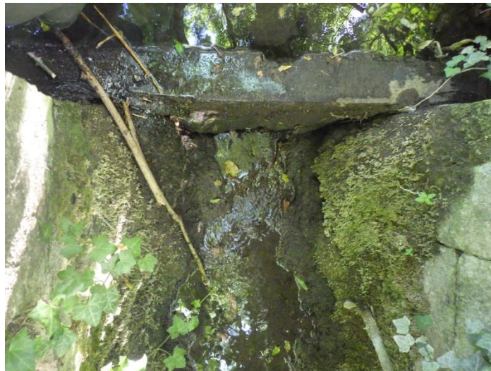
Fig. 26. Aval direct du seuil à l'étiage (160 l/s)
