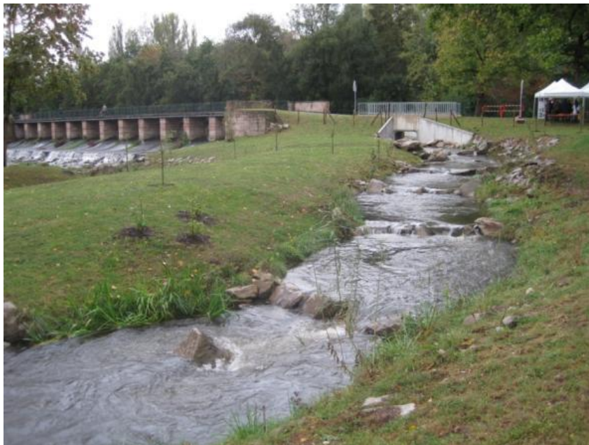
Fig. 29. Rivière de contournement du barrage d'Avolsheim sur la Bruche (67)
