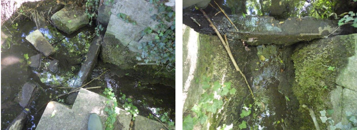
Fig. 11. Seuil du moulin Bruet
