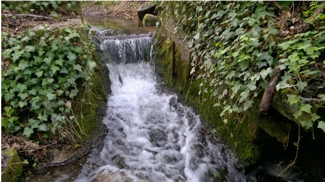
Fig. 1. Ouvrage de prise d'eau du moulin Bruet
