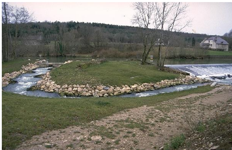
Fig. 30. Rivière de contournement du barrage de Châtillon-sur-Lison sur la Loue (25)
