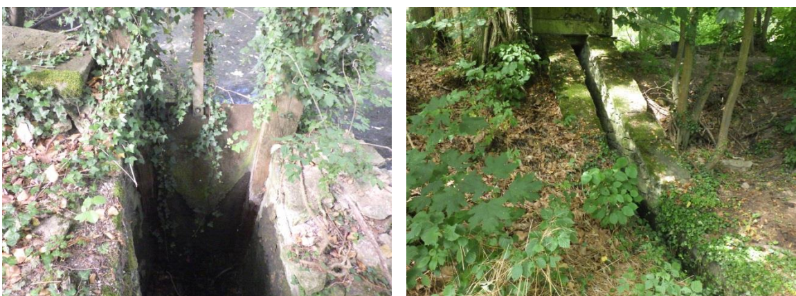
Fig. 10. Ouvrage de décharge du bief
