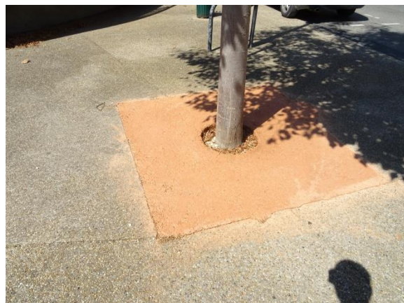
Trottoirs très fréquentés avec mise en place d'un mélange de résine et copeau de bois
