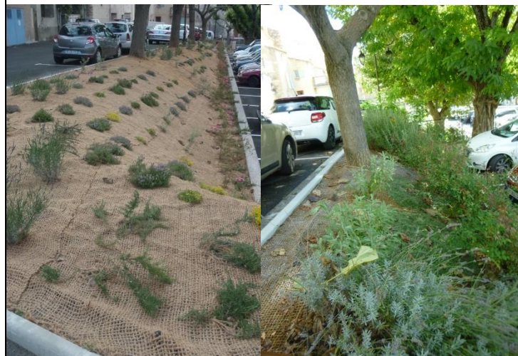
Château Arnoux Saint Auban (04) : Végétalisation d'un talus sur bâche biodégradable
