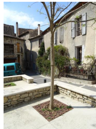
Grille en pied d'arbre et préservation d'une fosse de plantation avant l'installation des vivaces
