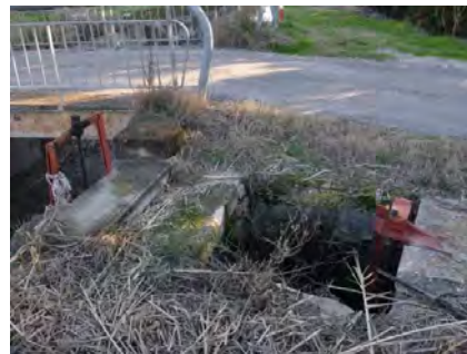
Figure 4-11 : Exemple de prise d'eau sur le canal de Craponne : vanne des arrosants (gauche) et de l'ASCO (droite)
