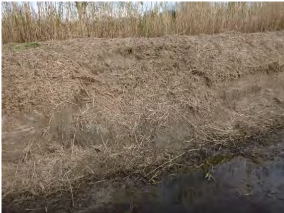
Figure 54 : Glissement du bord droit en terre à l'aval du Vieux Pont
