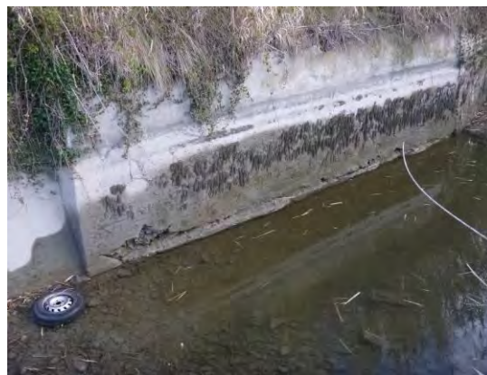
Figure 53 : Maçonnerie à reprendre sur une dizaine de mètres en rive droite en aval du barrage de Moulès
