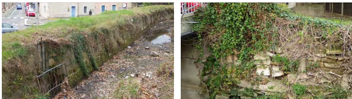
Figure 3-30 : Revêtement rive gauche du canal et système racinaire d'un arbre détériorant la maçonnerie en rive droite
