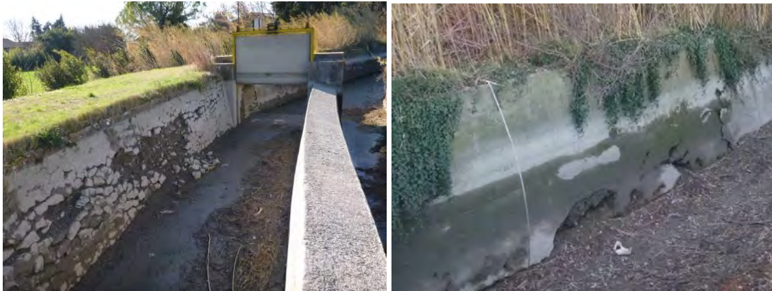
Figure 3-13 : Exemples de maçonnerie déchaussée et de dégradation des bajoyers
