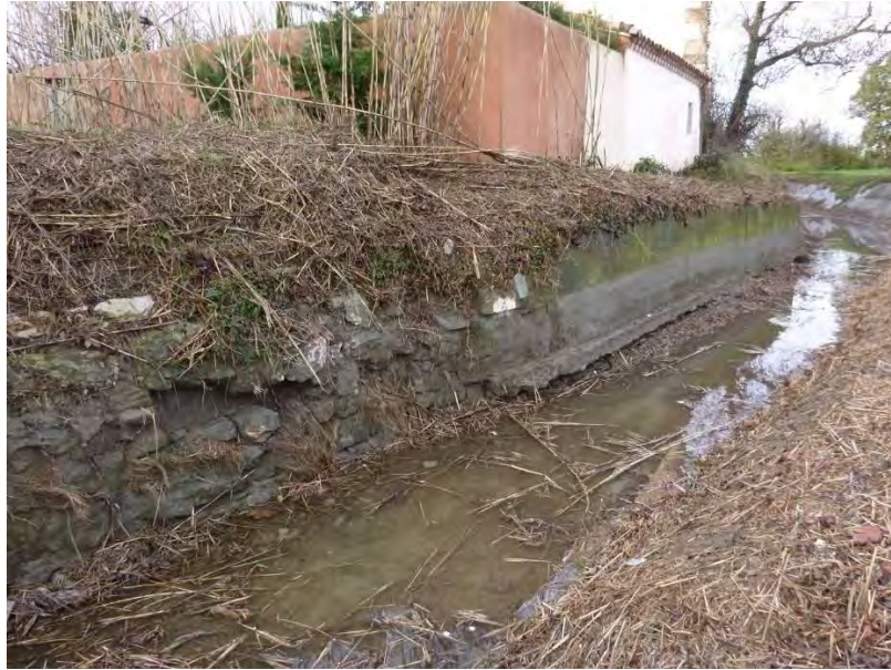
Figure 85 : Mur endommagé - Rive gauche du canal juste en aval du pont de Charmet (rond point de Pont de Crau/route d'Eyguières)
