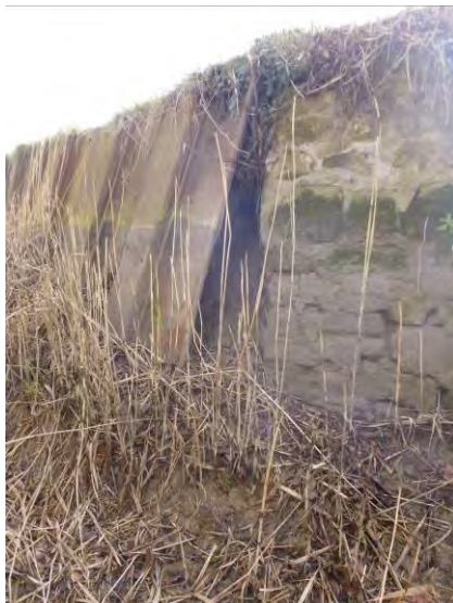
Figure 79 : Basculement des palplanches en rive gauche du canal (entre le pont d'Eymard et la DR83)
