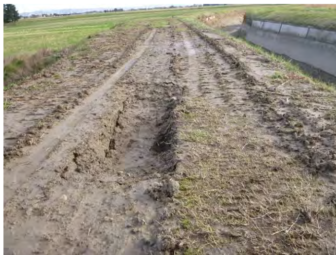
Figure 69 : Affaissement de la rive droite due au passage de véhicule (GPS N 43 39.399 ; E 4 42.089)
