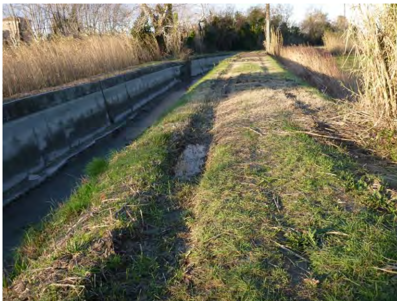
Figure 74 : Ornières en rive droite dues au passage de véhicules
