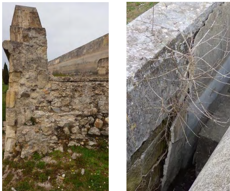
Photo n° 1 : Impact de la végétation sur la structure de l'aqueduc
