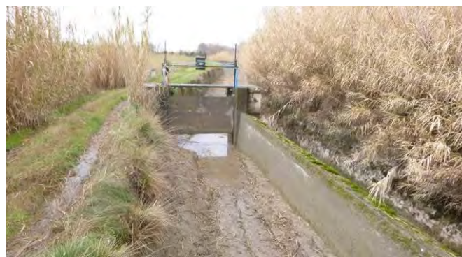
Figure 3-23 : Tablier amont de la vanne à modules du barrage de Moulès
