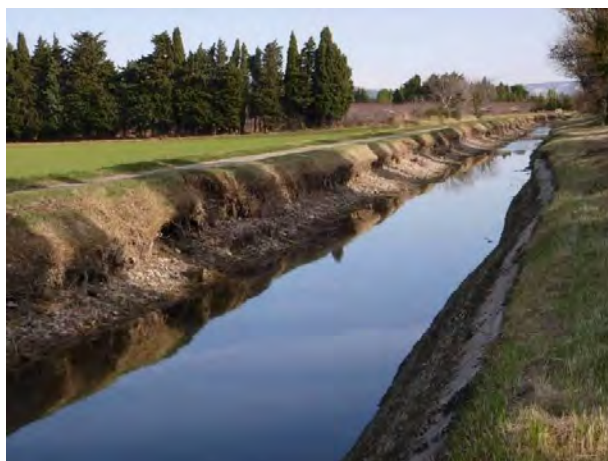
Figure 6 : Affouillements des berges en terre (vue de l'aval vers l'amont).
