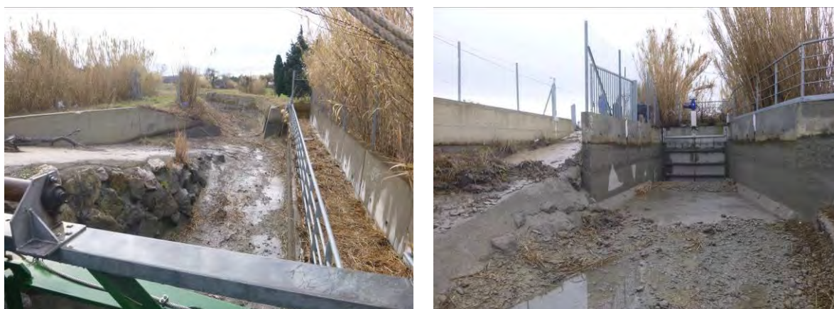
Figure 3-20 : Tête amont (gauche, photo A) et Tête aval (droite, photo B) du siphon des Muses
