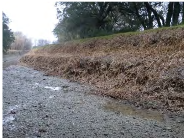
Figure 38 : effondrement du bord droit en terre à l'amont du moulin de Chambremont
