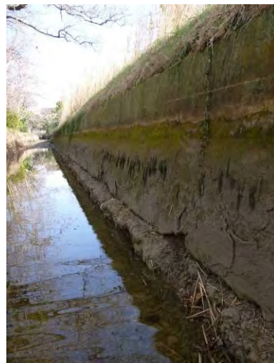
Figure 41 : Affouillement du béton en rive gauche
