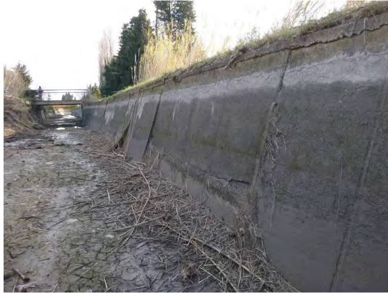
Figure 71 : Canal en aval du pont de Boussicaud (vu d'aval en amont) : plaques fendues horizontalement et/ou décalées
