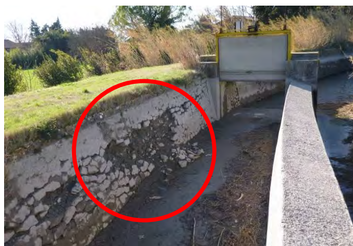
Figure 3-24 : Barrage de Rabet : Effondrement de la maçonnerie
