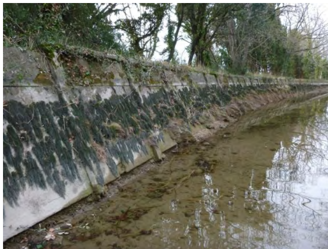
Figure 20: Plaques de bétons en mauvais état, rive gauche
