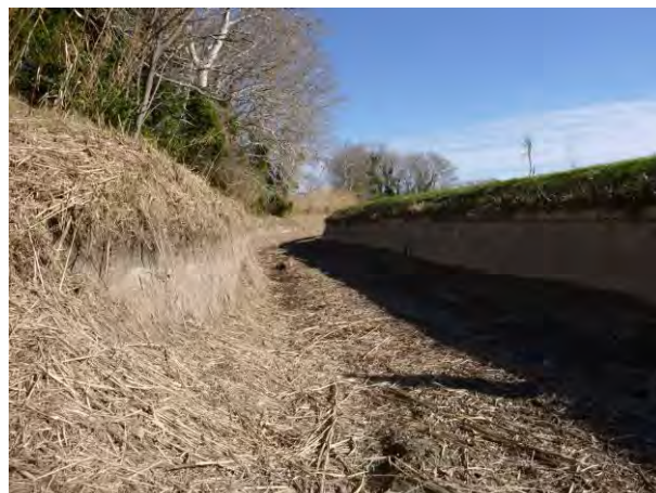
Figure 48 : Amont du pont de Bellevue - Affouillement au niveau de la berge bétonnée du canal en rive gauche (gauche), et sur les berges en terre en rive droite (droite)
