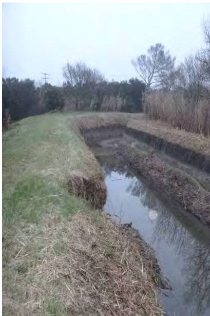
Figure 38 : effondrement du bord droit en terre à l'amont du moulin de Chambremont
