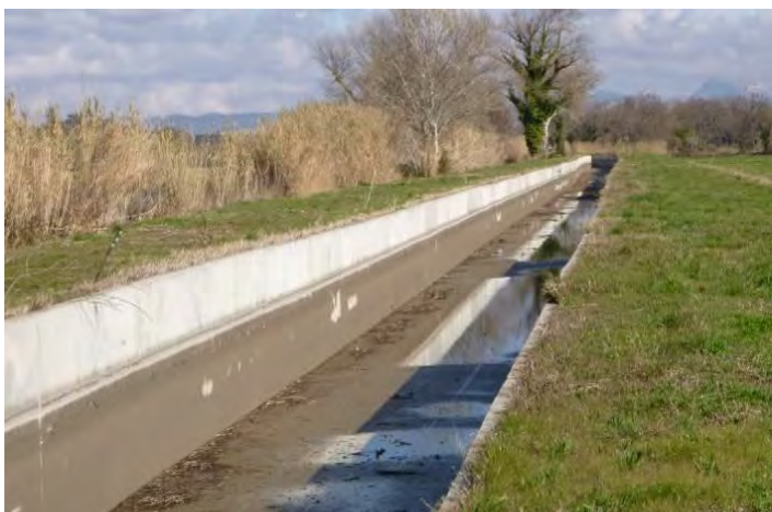
Figure 3-8 : Exemple de protection par voile béton en T
