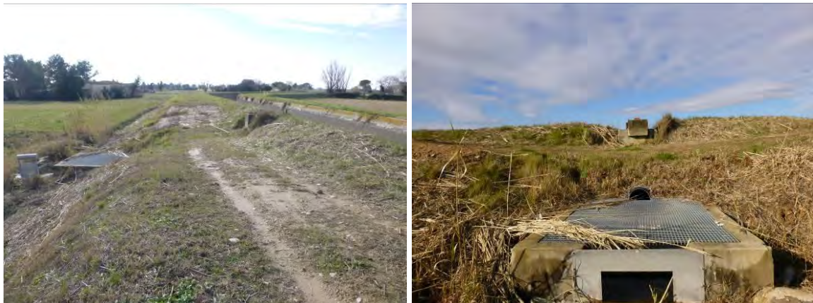
Figure 65 : Abaissement de la digue au passage des prises d'eau en rive gauche, entre le pont de Servanne et le pont de Rabet
