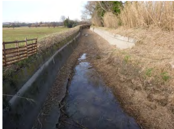
Figure 55 : Affouillement en RG à l'aval du pont du Mas Méou
