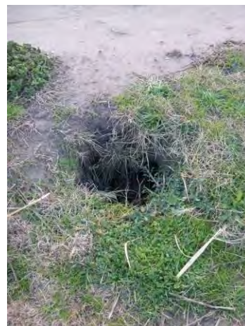
Figure 57 : Trou sur la digue du canal en rive gauche (longueur de la galerie supérieure à 1m80)
