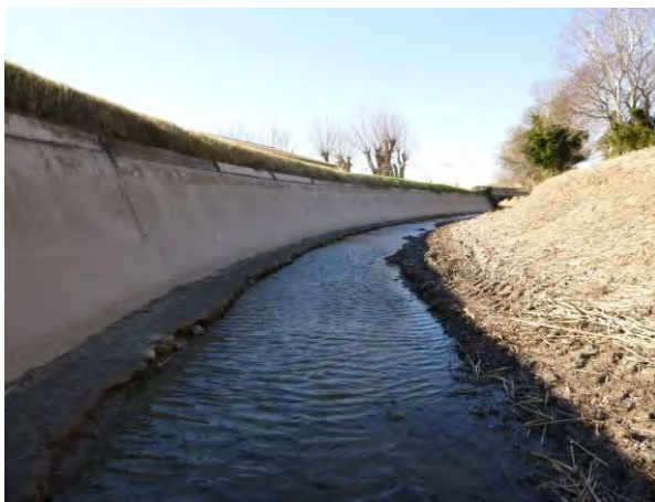
Figure 48 : Amont du pont de Bellevue - Affouillement au niveau de la berge bétonnée du canal en rive gauche (gauche), et sur les berges en terre en rive droite (droite)
