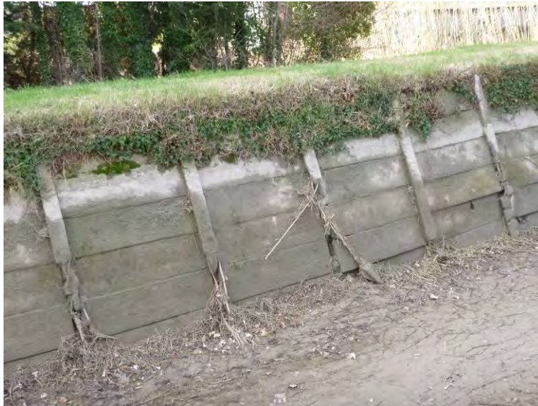
Figure 68 : décalage des plaques de béton et ferrailage visible (Rive gauche, en amont de la prise n°58)
