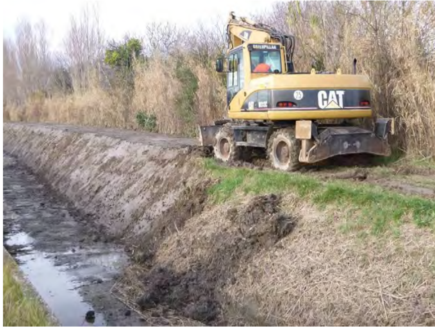
Figure 77 : Travaux de curage et recalibrage en cours - rive gauche en aval du pont coadjuteur
