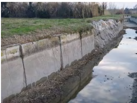
Figure 52 : Avancée des plaques en rive droite à l'amont du pont de Moulès
