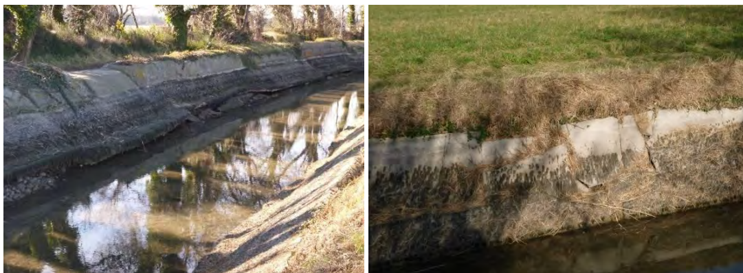
Figure 5 : Mur déchaussé en rive gauche du canal (gauche) et mur ponctuellement endommagé (droite) - aval du Pont du Mas d'Espagne
