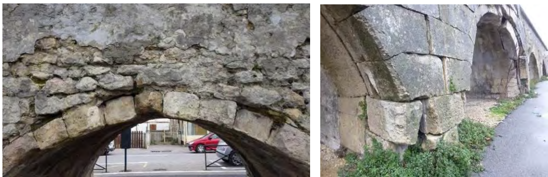
Figure 3-26 : Désordres sur la structure de l'aqueduc
