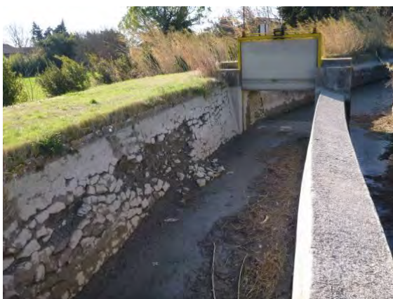
Figure 66 : Barrage AMIL vu depuis l'amont avec effondrement du mur en rive gauche
