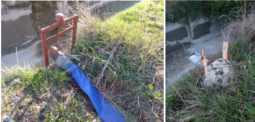
Figure 63 : Pompe mise en place en rive droite pour évacuer l'eau des parcelles voisines du canal en cas d'inondation, au niveau de la prise 17 (gauche), et entre les prises 17 et 18 (droite)
