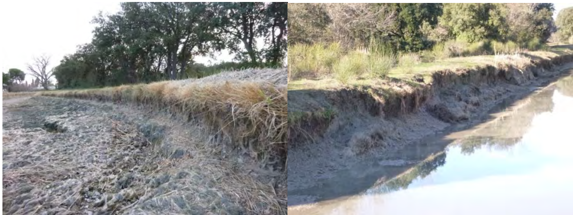
Figure 28 : Affouillement et effondrements en rive droite du canal
