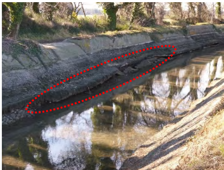
Figure 3-5 : Exemple de désordre : sous cavage
