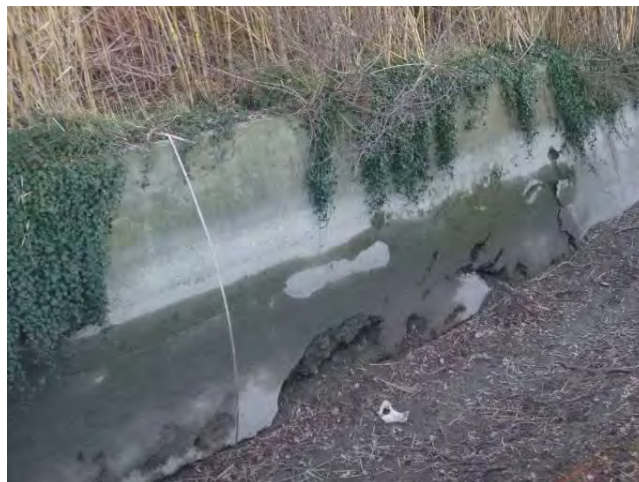
Figure 64 : Mur béton endommagé, en RG à l'aval du barrage de Rabet (sur une 20aine de mètres)
