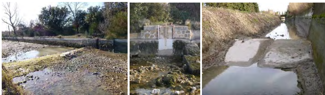
Figure 4-18 : Exemples de seuils mis en place en travers du canal pour rehausser la ligne d'eau
