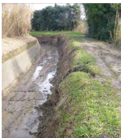
Figure 3-12 : Exemple de cercles de glissement sur la crête des berges
