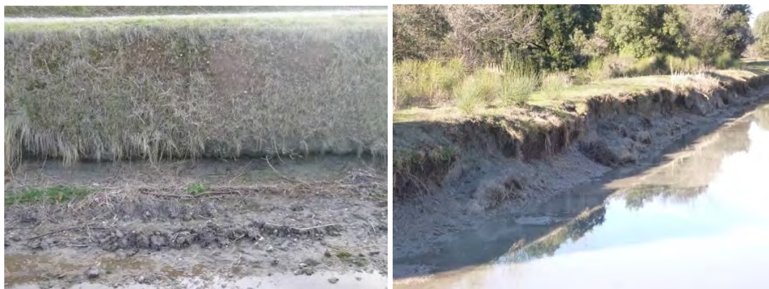
Figure 3-1 : Exemple de désordre en pied de talus sans protection (gauche) et d'érosion de surface (droite)
