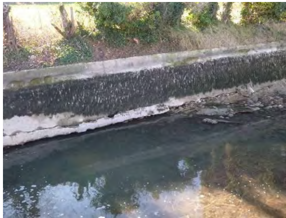
Figure 3 : déchaussement du mur en rive gauche du canal, entre le point de mesure et le pont du Mas d'Espagne.
