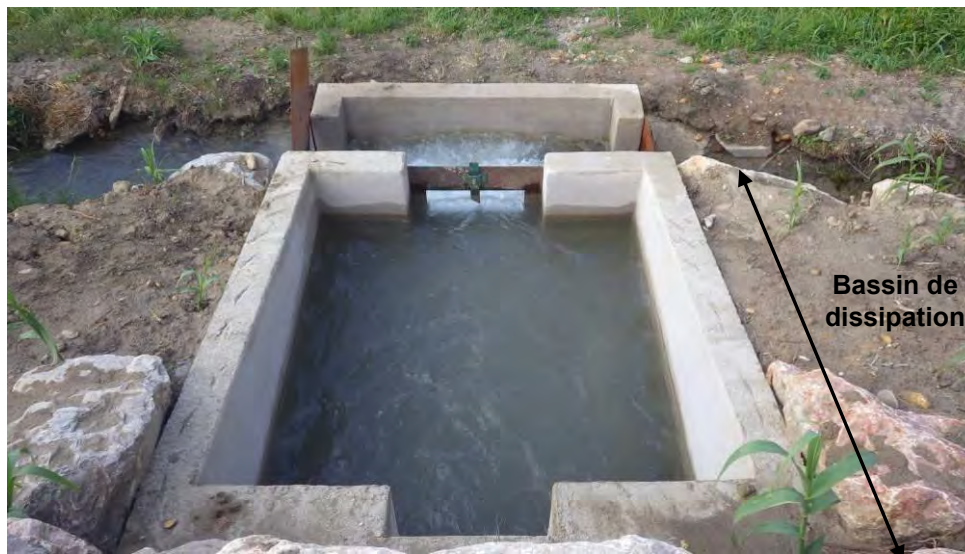
Figure 4-13 : Photographies d'une section de contrôle et de son bassin de dissipation
