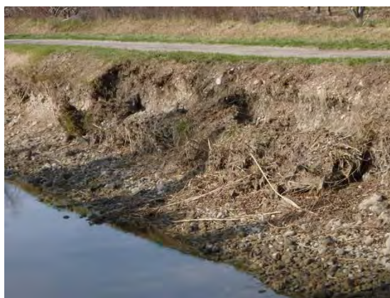
Figure 7 : Effondrement de la berge en rive droite - entre le pont du Mas d'Espagne et le Pont de Brahis (GPS N43 41.206 ; E4 59.196)
