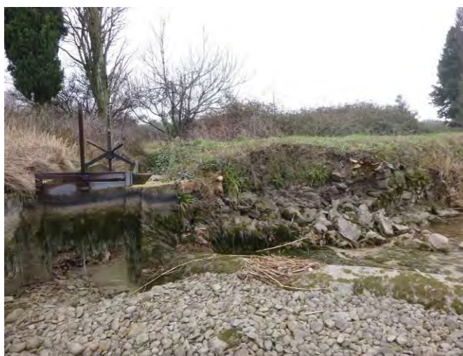
Figure 33 : Effondrement du mur au niveau de la prise 19 bis en rive gauche
