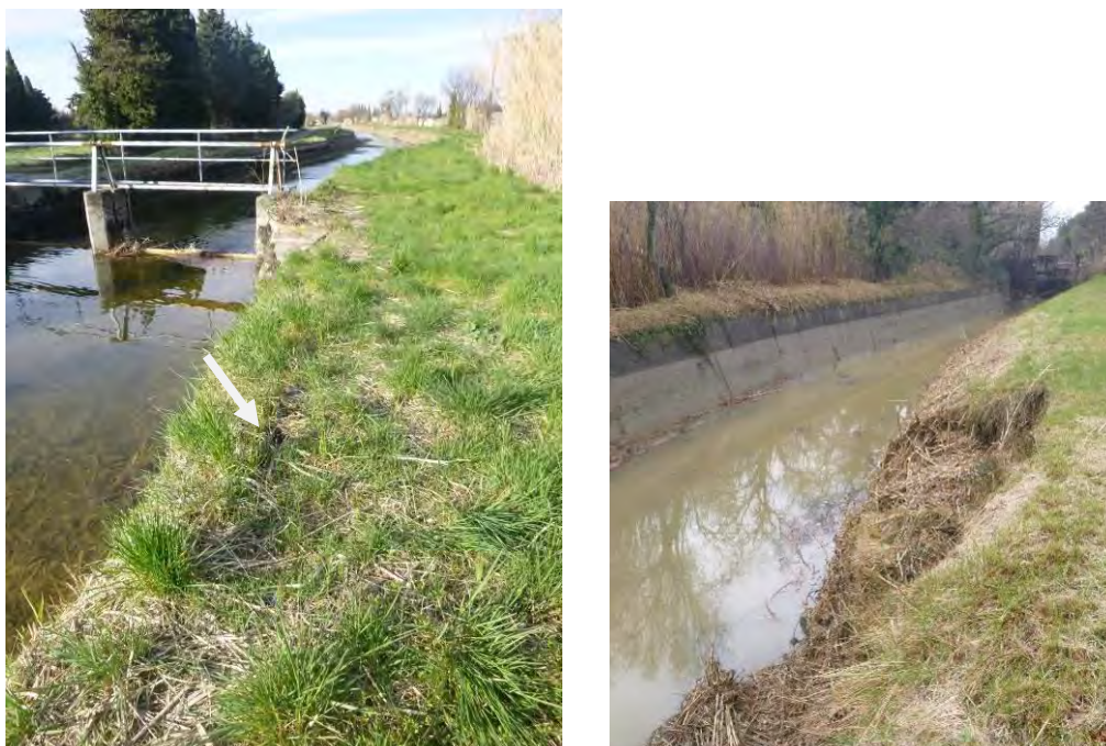
Figure 3-2 : Exemple de désordre en tête de talus sans protection
