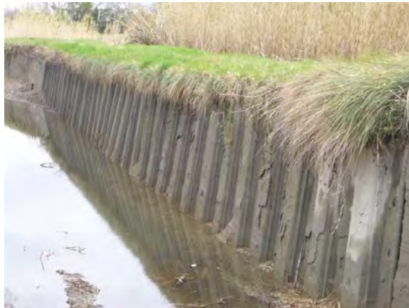
Figure 3-11 : Exemple de protection par un rideau de palplanches
