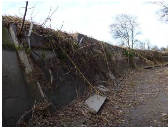
Figure 51 : Mur à reprendre en rive gauche en amont de la prise 39 en rive gauche
