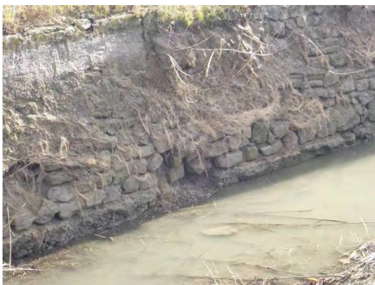
Figure 3-9 : Exemple de protection en maçonnerie
