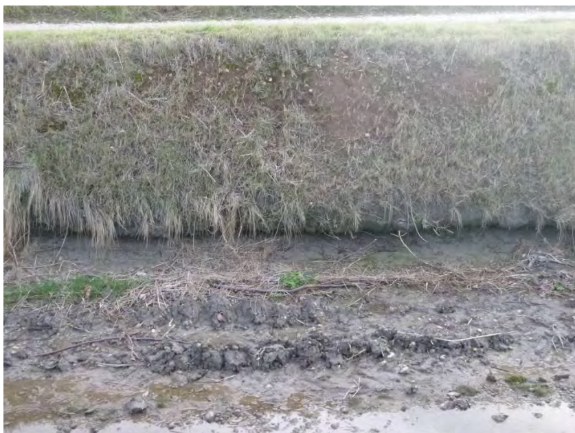
Figure 76 : Affouillements en rive gauche, en aval du pont coadjuteur (50 mètres linéaires)
