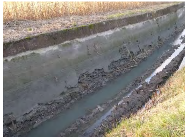
Figure 72 : affouillement de la rive gauche (100m linéaire entre les prises 59 et 59bis en RG)
