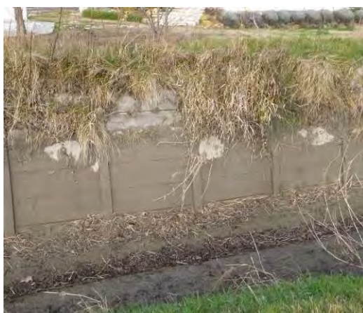
Figure 3-6 : Exemples de protection par dallettes béton
