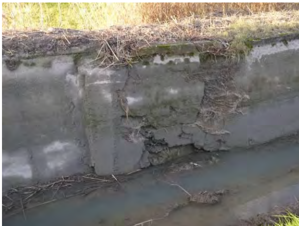
Figure 72 : affouillement de la rive gauche (100m linéaire entre les prises 59 et 59bis en RG)
