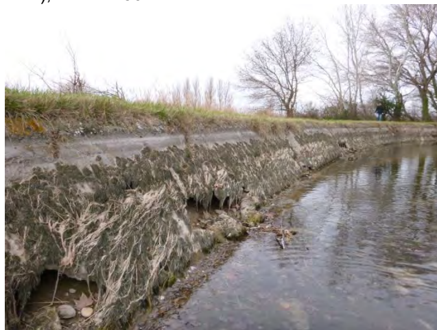
Figure 24 : Béton en mauvais état vu vers l'amont
