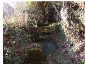
Figure 4-12 : Exemple de bassin de calibrage insuffisamment entretenu
