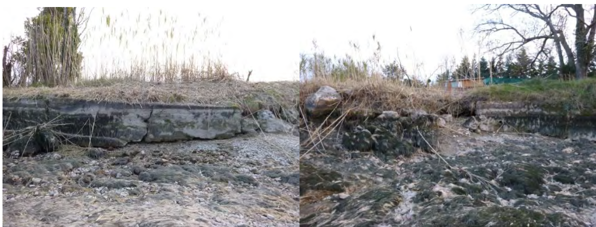
Figure 30: Effondrement localisés des murs en rive gauche
