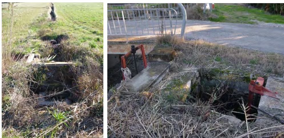
Déversoir hors service à réhabiliter (gauche) ; prise à sécuriser (mise en place de caillebotis) (droite)
