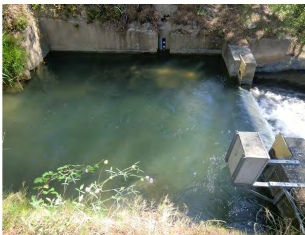
Exemple de vanne motorisée télégérée par un capteur situé dans un bassin de calibrage au départ d'une antenne du canal de la vallée des Baux (JPh LUC – BRLi©2012)
