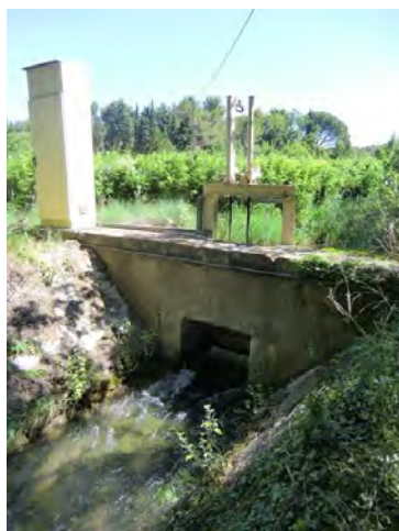
Exemple de vanne motorisée télégérée par un capteur situé dans un bassin de calibrage au départ d'une antenne du canal de la vallée des Baux (JPh LUC – BRLi©2012)
