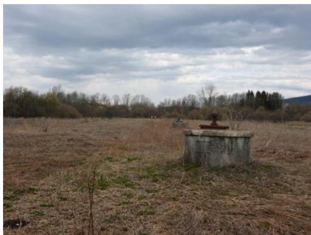
Ouvrage du champ captant
