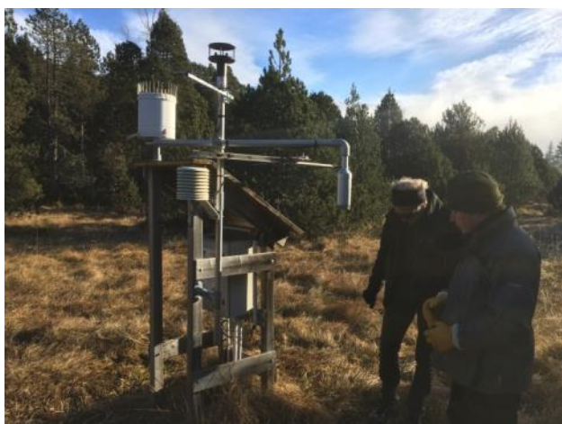
Station météo de la tourbière du col (F. Chambaud)
