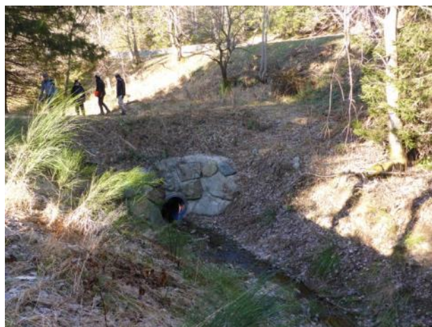
Ruisseau du Luitel recalibré – Vue aval (F. Paron)
