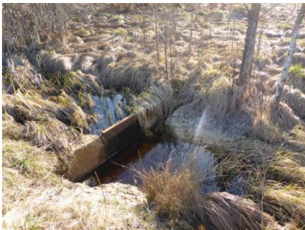
Seuil de relèvement ruisseau 1 : tourbière active
