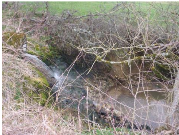
Déversoir d'orage et eau d'assainissement (RD)
