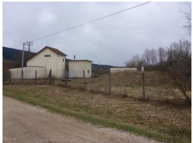
Station de pompage : zone aval du marais de Vaux
