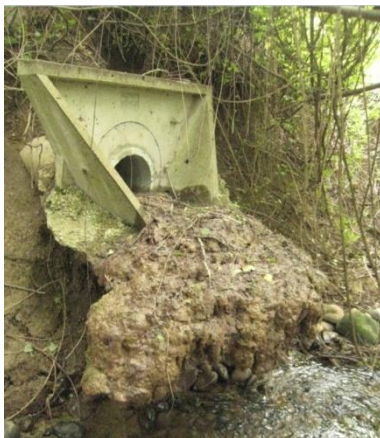
Figure 7 : sortie de buse dégradé en 2010 et réparé et ouvrage affouillé non réparé
