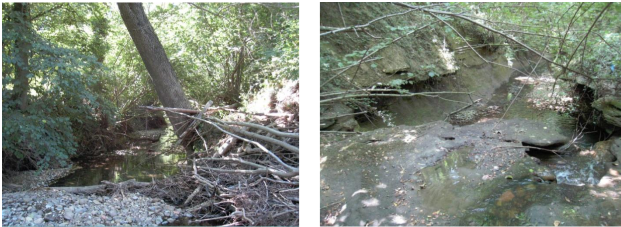
Figure 3 : arbre affouillé par la crue de 2013 sur le Chalon et érosion de la molasse sur la Savasse (secteurs amont 1)
