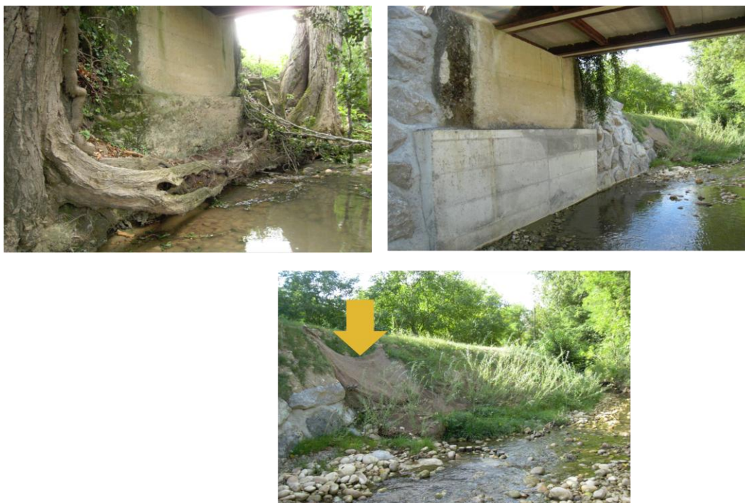
Figure 8 : confortement des berges au droit du pont du Saladot sur la Joyeuse
