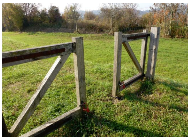
Figure 2 : barrières limitant les accès motorisés sur les crêtes de digues
