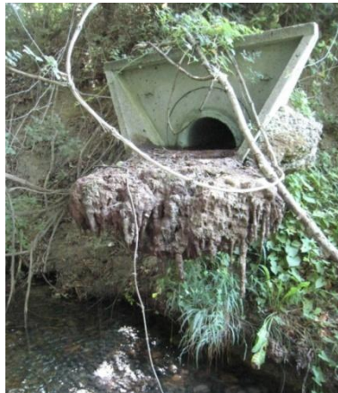
Figure 7 : sortie de buse dégradé en 2010 et réparé et ouvrage affouillé non réparé
