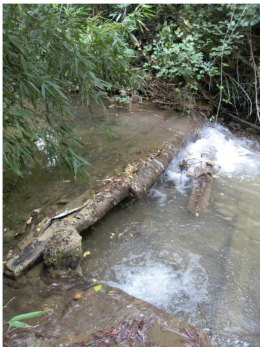
Figure 12 : seuil rustique d'une ancienne prise d'eau sur la Joyeuse favorisant le colmatage du lit
