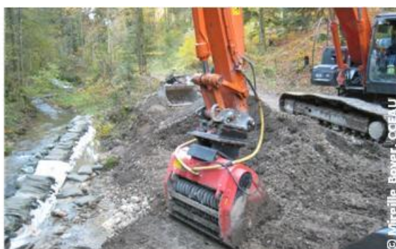
Concassage des terres colonisées par godet-concasseur
