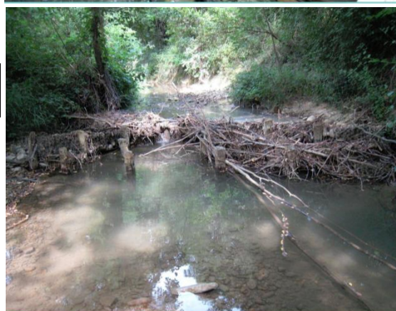
Figure 13 : vestiges de seuils "piscicoles" sur le Bagnol et la Savasse
