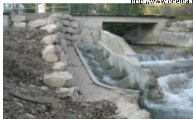
Figure 53 : Exemples d'aménagement piscicole (rampe rugueuse et passe à bassins mixte)
