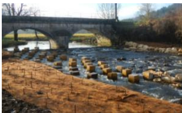
Figure 53 : Exemples d'aménagement piscicole (rampe rugueuse et passe à bassins mixte)
