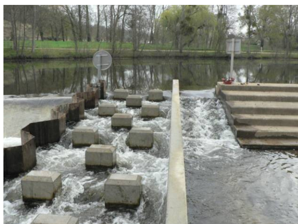
Barrage de Rhodas (24)
