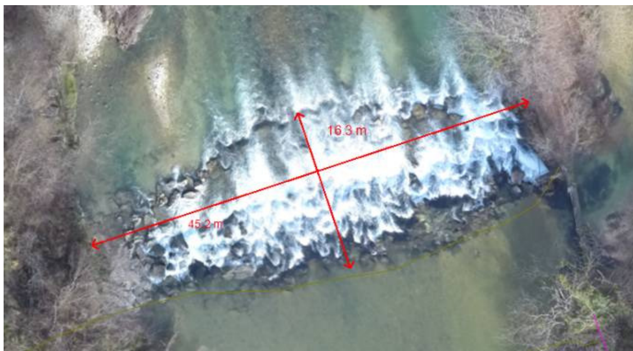
Figure 54 : Vue aérienne du seuil du canal Sibille.
