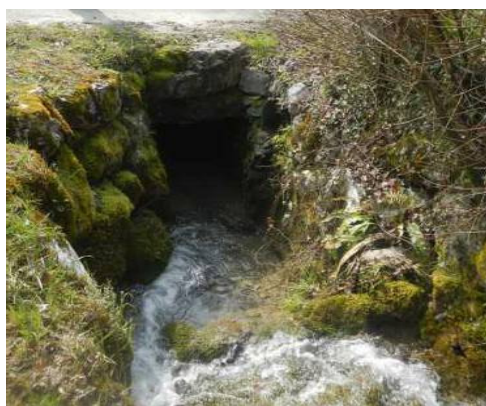
Figure 38 : Ouvrage PI-OJ1 - Amont
