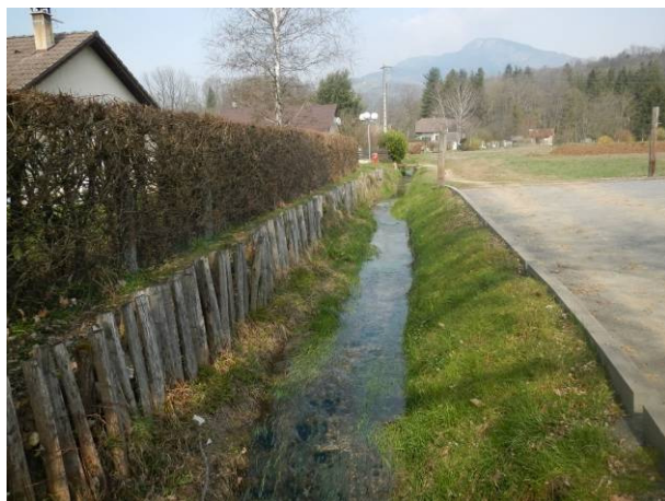
Pisserotte amont RD1006 (caserne pompiers)
