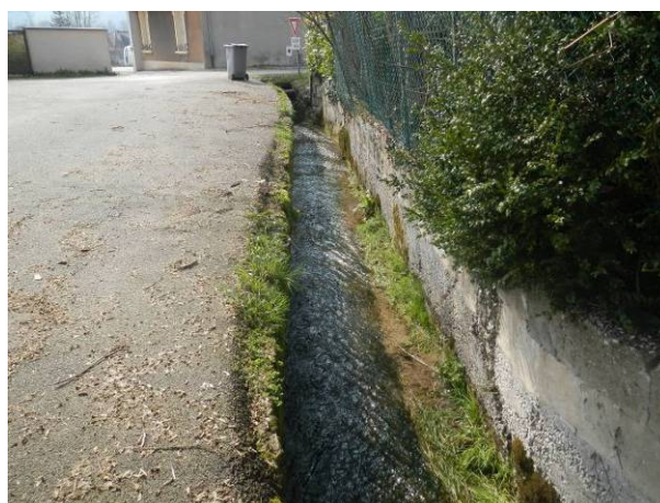
Lit entièrement artificialisé entre deux murs
