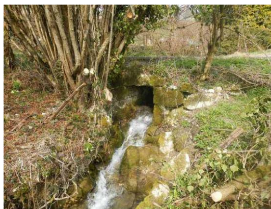
Figure 39 : Ouvrage PI-OJ1 - Aval
