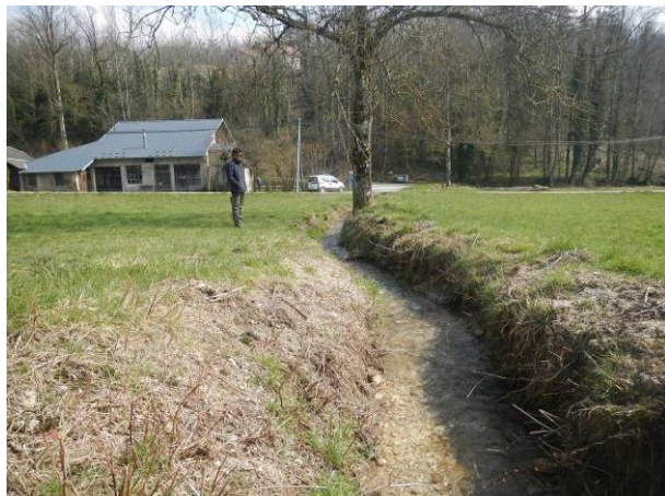
Zone de débordement (amont OF-Pl08)
