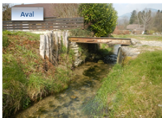
Lit entièrement artificialisé entre deux murs
