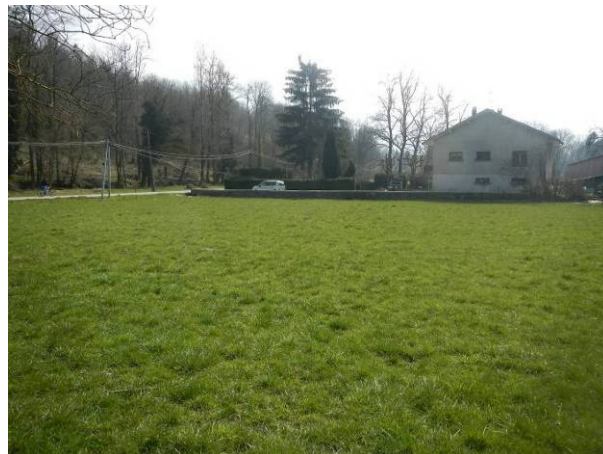
Muret qui protège l'habitation et la ferme à l'aval
