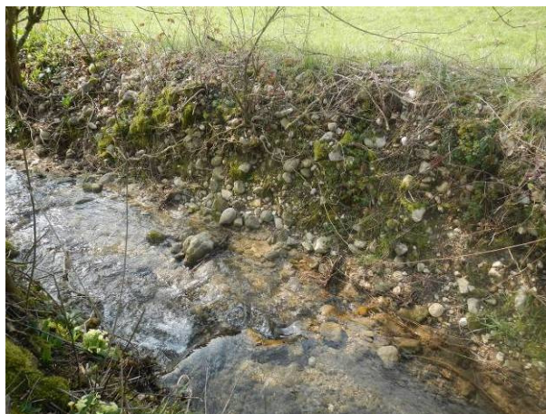
Traces d'érosion importantes
