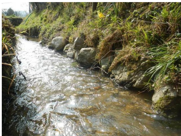
Anciennes protections de pieds berge (en mauvais état) – traces d'érosion et de glissement
