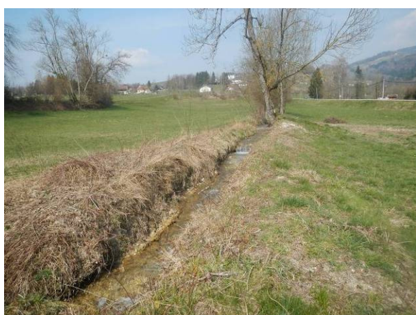
Lit perché (berges de très faibles hauteurs) et dépôts (merlons de curage historiques)
