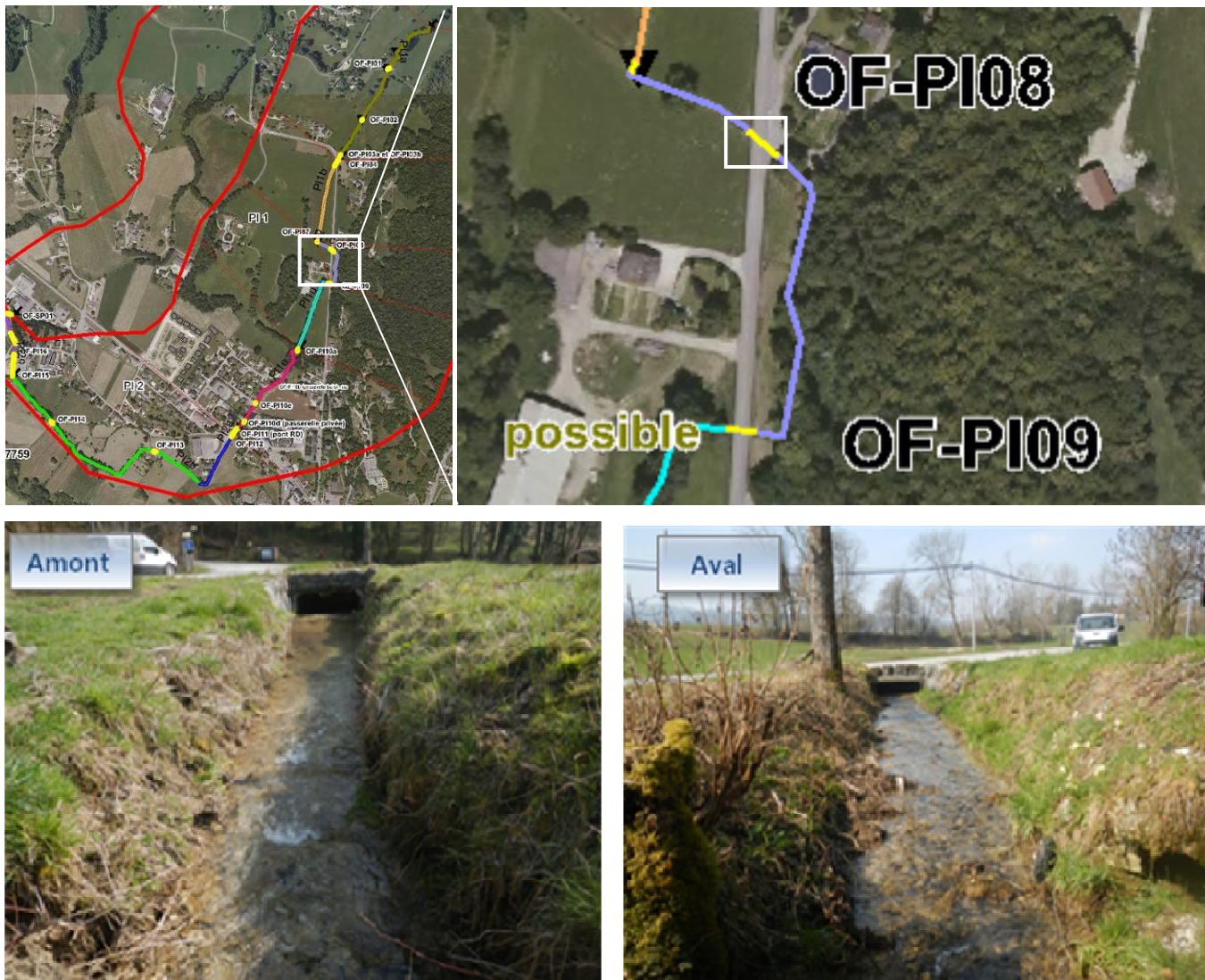
Figure 49 : Ouvrage OF-PI08 sous la RD à curer
