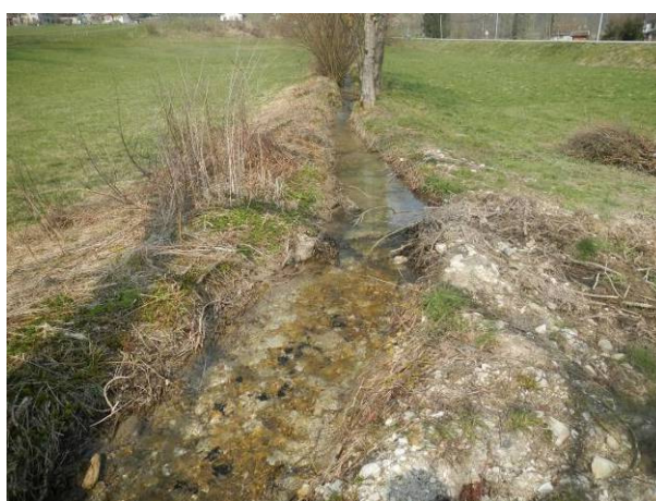
Lit perché (berges de très faibles hauteurs) et dépôts (merlons de curage historiques)
