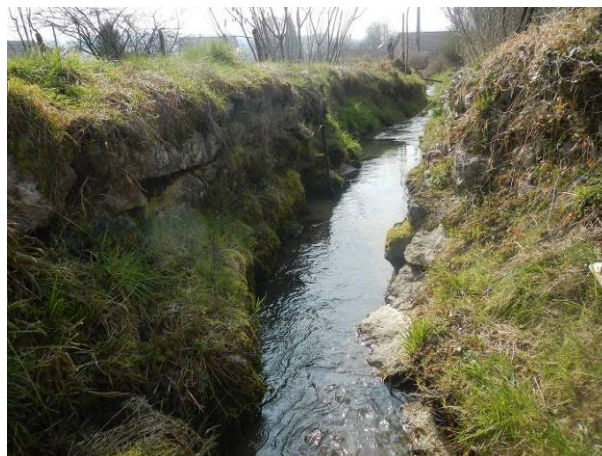
Anciennes protections de pieds berge (en mauvais état) – traces d'érosion et de glissement
