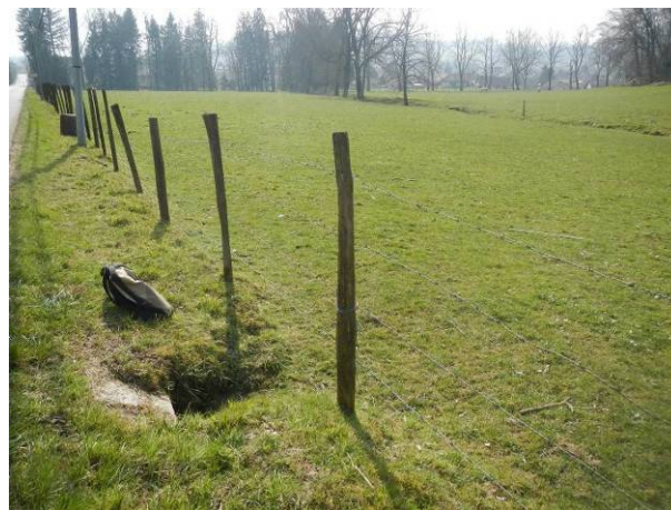
Sortie de la buse de drainage sous la route RD921
