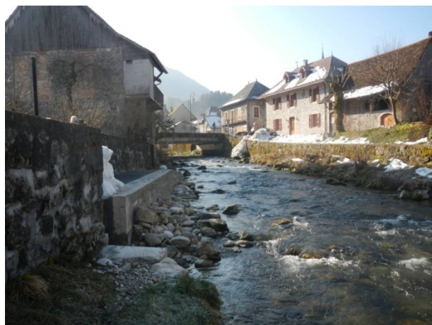
points de débordements en aval RG du pont de la RD912 (OF-GV6) : ~30 ml
