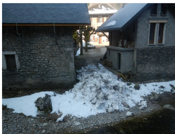
points de débordements très ponctuels (accès cours d'eau voirie)
