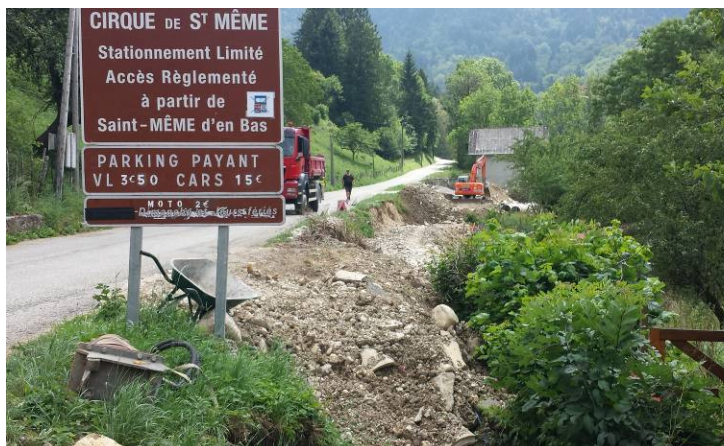
Travaux en cours (été 2016)
