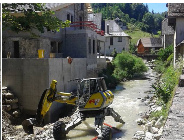
Travaux en cours (été 2016)
