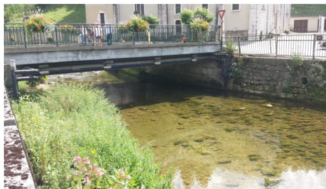
Aval OF-CO10 (pont communal).
