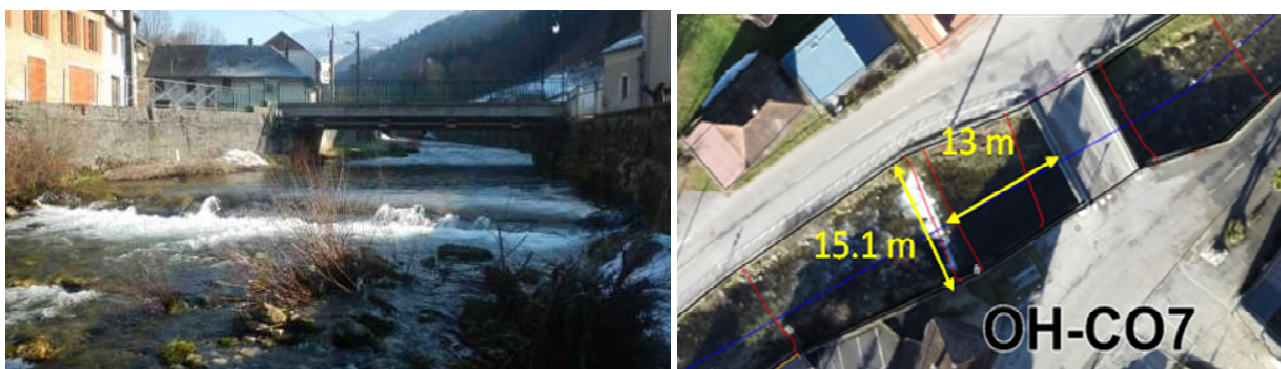
Seuil ROE39049 sur le Cozon (en arrière plan pont communal)
