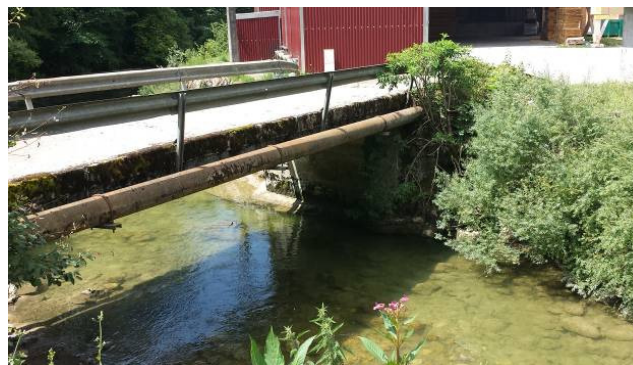
Aval passerelle d'accès à la Scierie (OF-GV7)
