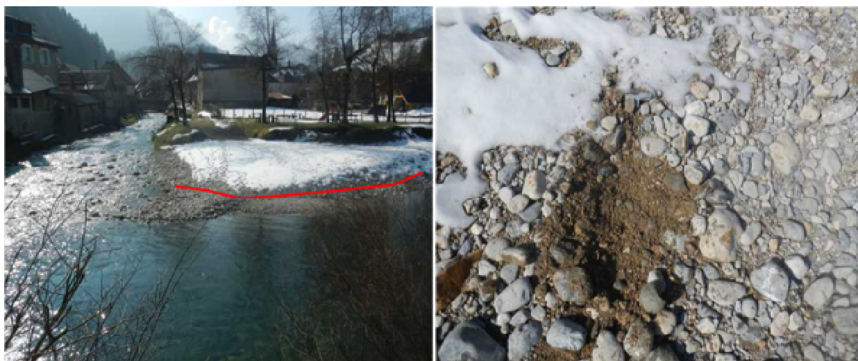
Figure 12 : Atterrissement au niveau de la confluence Guiers vif - Cozon
