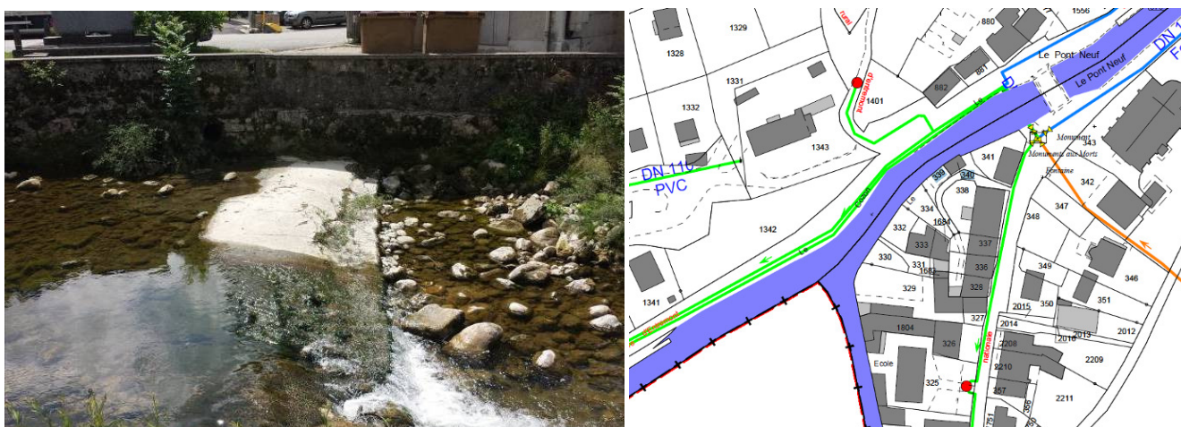
Figure 24 : Seuil ROE39049 sur le Cozon et réseaux
