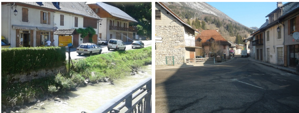
Figure 8 : Points bas au niveau de la boulangerie et voie de circulation empruntée par les débordements (en rive droite du Guiers Vif)
