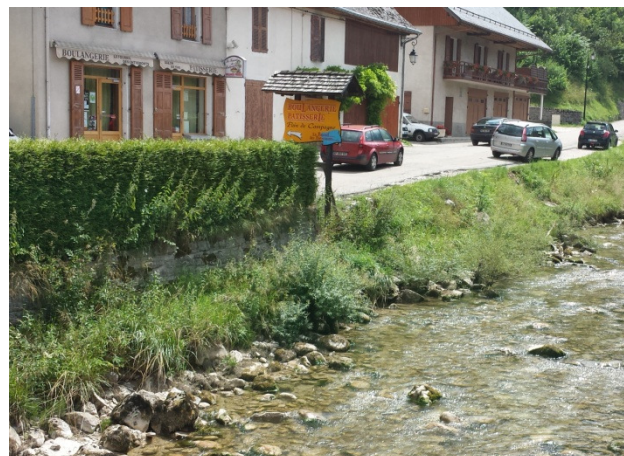
points de débordements en amont RD du pont de la RD912 (OF-GV6) : ~ 30 ml
