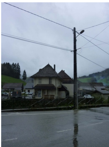
2/ Mat d'éclairage bois fixé sur poteau électrique béton.
