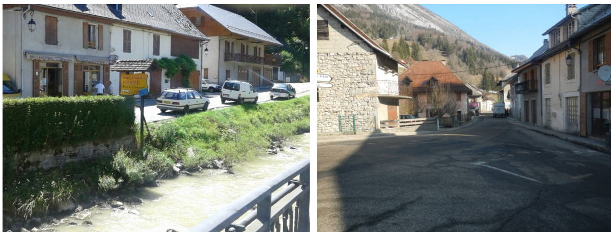
Figure 79 : Points bas au niveau de la boulangerie et voie de circulation empruntée par les débordements (en rive droite du Guiers Vif)
