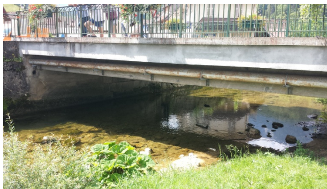
Amont OF-CO10 (pont communal).
