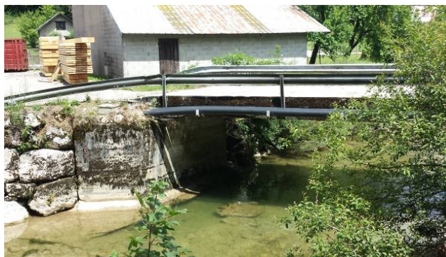
Amont passerelle d'accès à la Scierie (OF-GV7)
