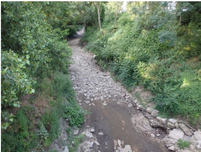
Garon à sec au niveau de la station de mesures S1 – Aval des 3 DO Grigny/Givors
