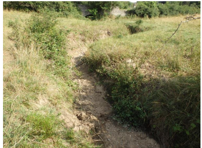
Merdanson d'Orliénas à sec au niveau de la station de mesures S2 – Aval Taluyers
