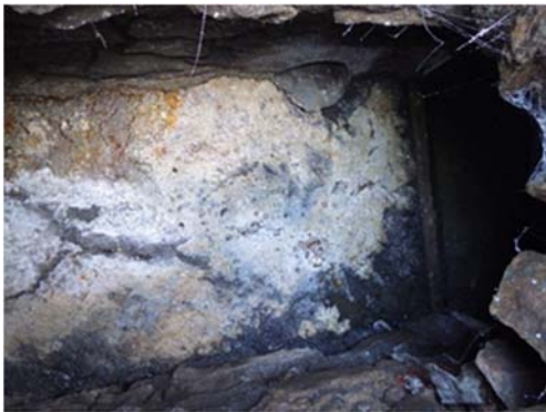
Dépôt, graisses, écoulement lent
