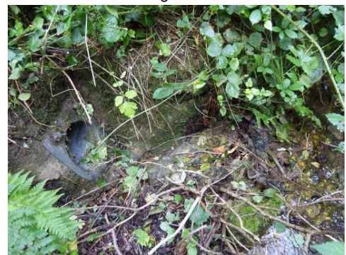
Clapet anti-retour arraché
