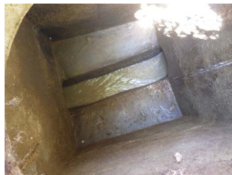
Infiltration et intrusion racinaire
