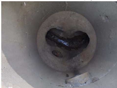
Route du Large Réseau unitaire connecté au réseau pluvial (regard SLA_14)
