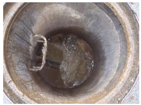
Le Villard – Bd. du Général de Gaulle Réduction de section (regard MOR_25)
