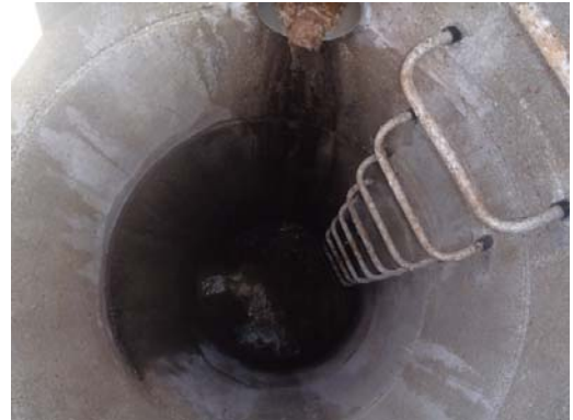
ZI de Chaponost – Route des Collonges Regard ZIC_07 : Dépôts de graisses
