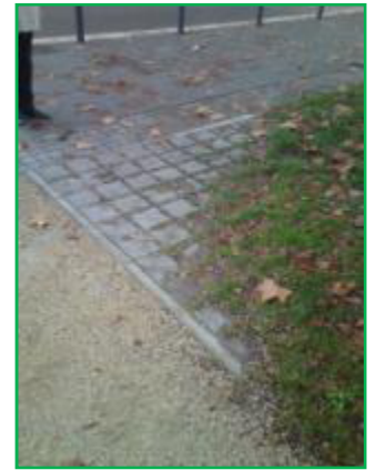
Angle d'une zone enherbée, passage de piétons, éviter les angles aigus, réfection pavés joint engazonné ; passage de la tondeuse.
