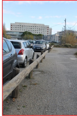
Accès en bicouche au parking du tennis
