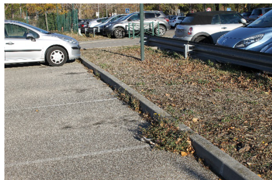
Parking au sud-ouest de l'hôpital
