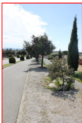
Trottoirs vieillissant en bi – couche, propice à la levée de végétation.
