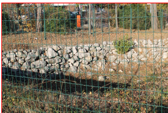
Bassin de rétention Parking de la rééducation fonctionnelle
