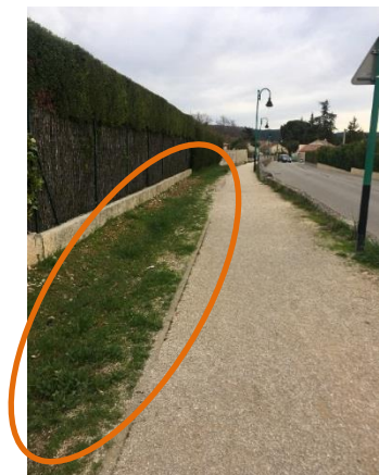
Accompagnement de voirie
