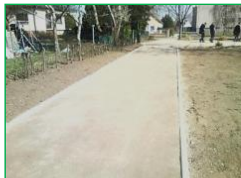
Revêtement stabilisé renforcé par liant avec un ph basique limitant la pousse des herbes et favorisant l'infiltration de l'eau : ne craint par l'érosion.
