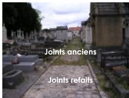
Angle d'une zone enherbée, passage de piétons, éviter les angles aigus, réfection pavés joint engazonné ; passage de la tondeuse.
