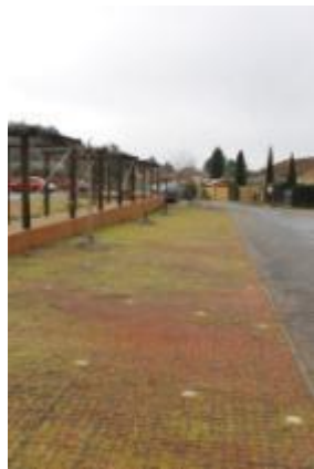
Parking avec système nid d'abeille (rempli de gravier ou engazonné) permettant de répondre aux normes pour les personnes à mobilité réduite favorisant l'infiltration de l'eau en milieu urbain.
