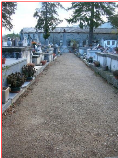
Stabilisé classique soumis à l'érosion et à la pousse régulière de la végétation si la fréquentation est faible.
