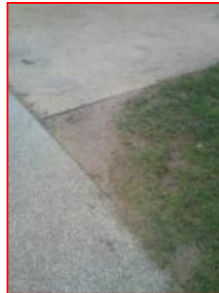
Angle d'une zone enherbée, passage de piétons, éviter les angles aigus, réfection pavés joint engazonné ; passage de la tondeuse.
