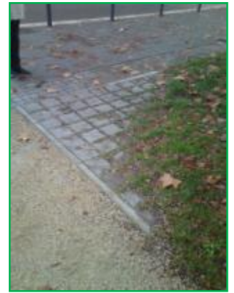
Angle d'une zone enherbée, passage de piétons, éviter les angles aigus, réfection pavés joint engazonné ; passage de la tondeuse.
