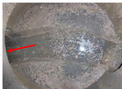
Vue intérieure regard EP
