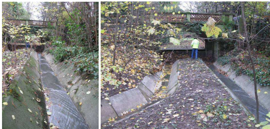
Fig. 12. Le ruisseau des Rigolettes - Passage à ciel ouvert boulevard des neuf clés
