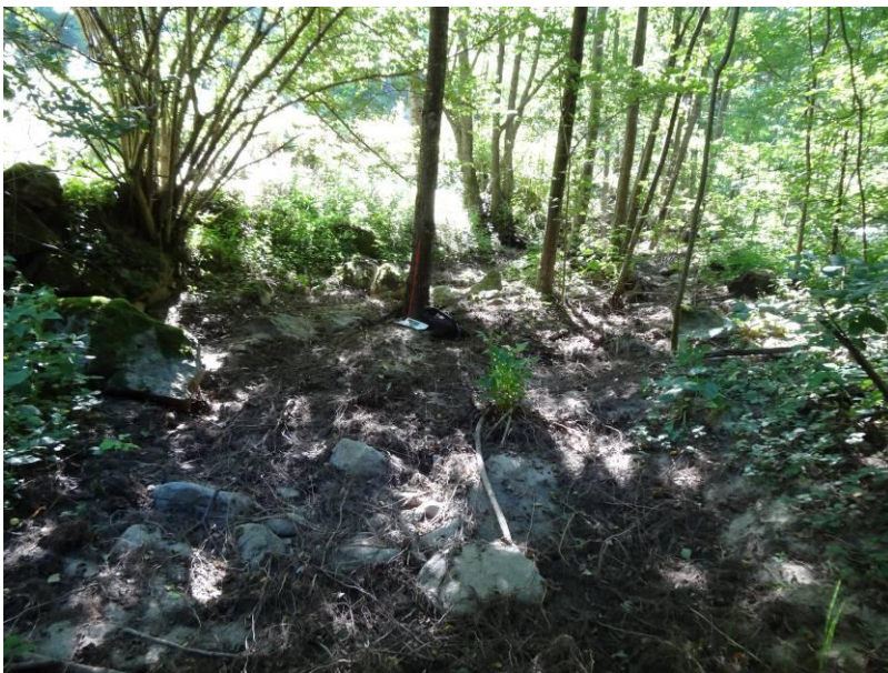
Fig 3 : érosion de berge de chenal
