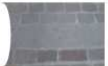
Pavés en granite avec joints dressés
