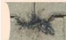
Désherbage thermique entre pavés autobloquants
