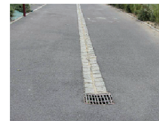
Caniveau central dans un lotissement (Guignen)
