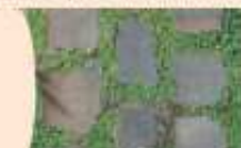
Végétation encouragée entre pavés jointés au sable
