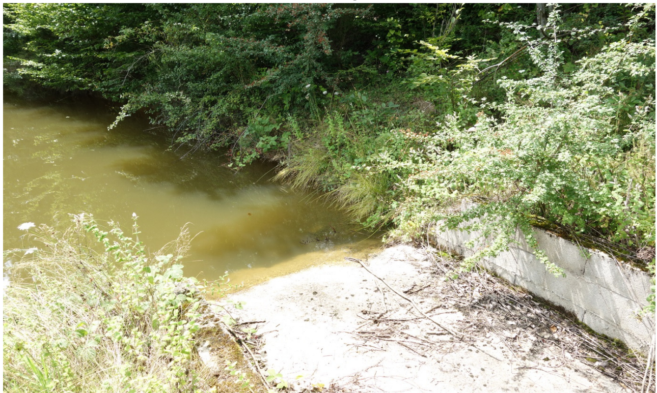
Deversoir rive gauche
