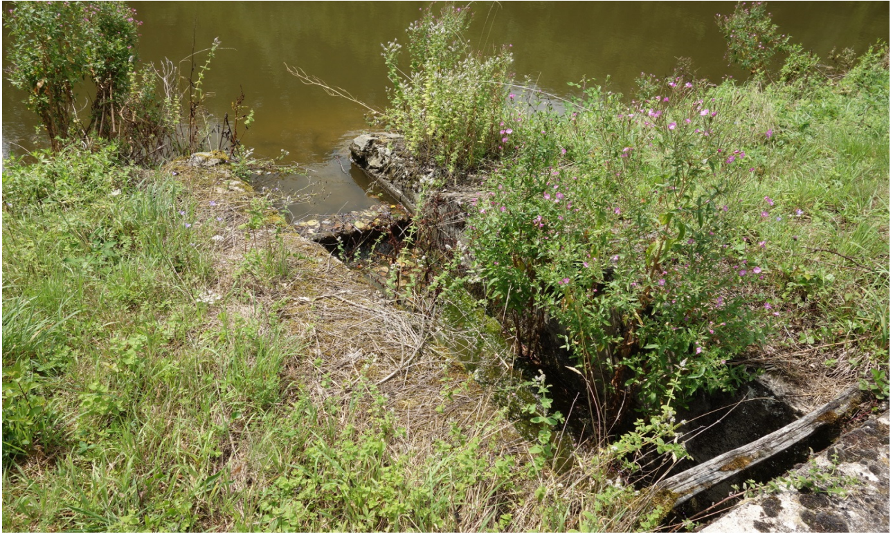
Deversoir rive droite
