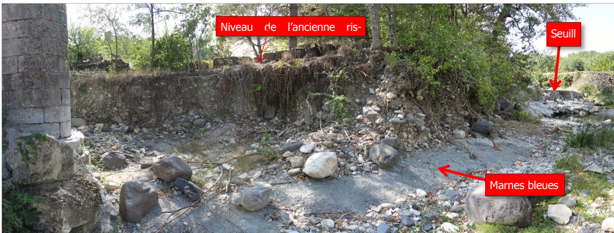
Figure 22 : vue depuis la travée T2 vers l'aval. On distingue le seuil, une passée de marnes bleues du Bédoulien inf. et le niveau de l'ancienne risberme. Cette dernière est érodée du fait de l'incision du lit.
