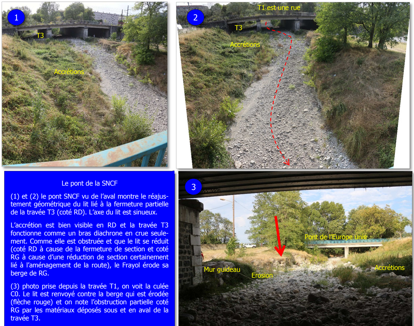
Figure 14 : (1) et (2) Elévation aval du pont SNCF, (3) vue de l'érosion de berge en rive gauche
