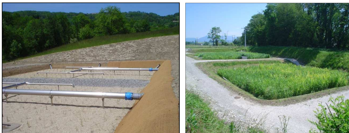
Fig. 6-a : Exemple de stations d'épuration filtres plantés de roseaux avant et après mise en fonctionnement
