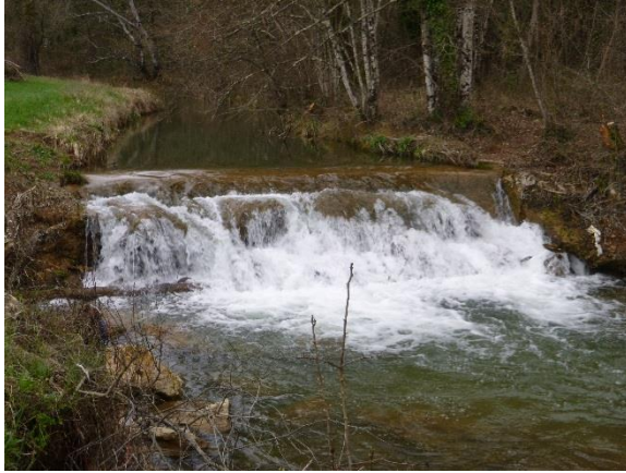
Figure 98 : Ouvrage du Pelcourt amont
