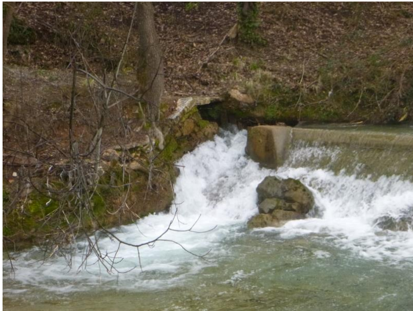
Figure 63 : Débit d'attrait au droit de l'ouverture en rive droite de l'ouvrage
