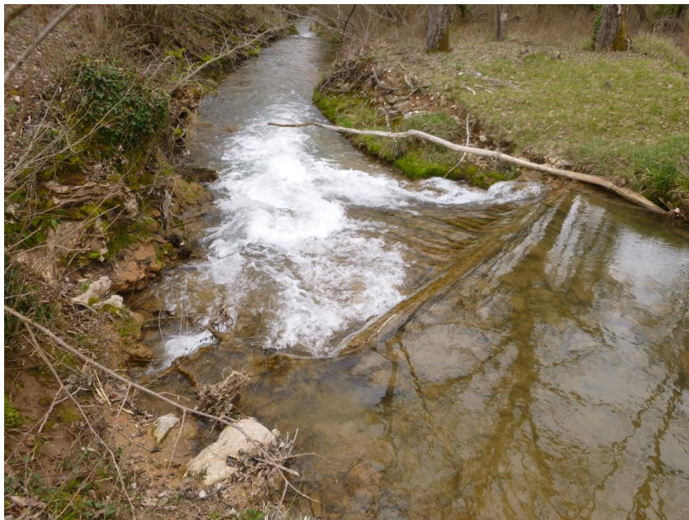
Figure 94 : Etat du comblement du seuil du Pelcourt aval
