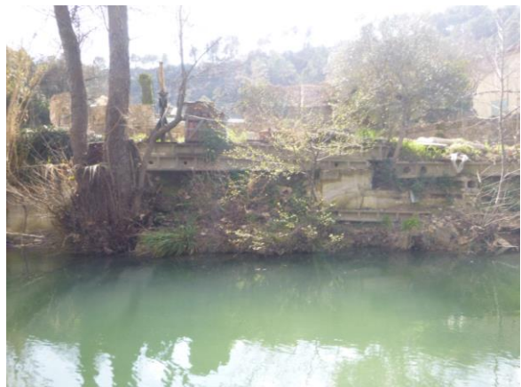
Figure 19 : Berges aménagées en amont du seuil d'Entrecasteaux
