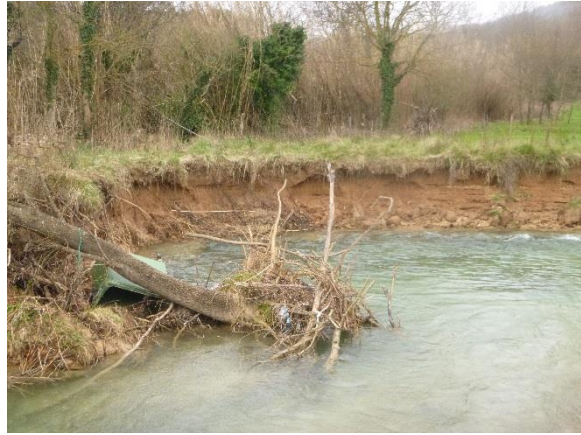
Figure 65 : Erosion de berge importante en bordure de parcelle privée située environ 500 m en amont du seuil
