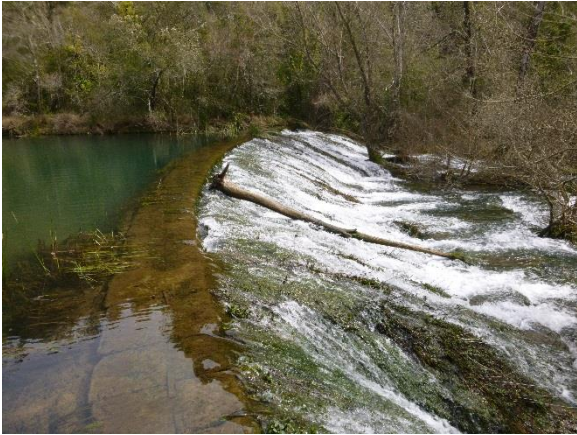
Figure 80 : Seuil de Bégon et accumulation de tufs formant un plan incliné à son aval direct
