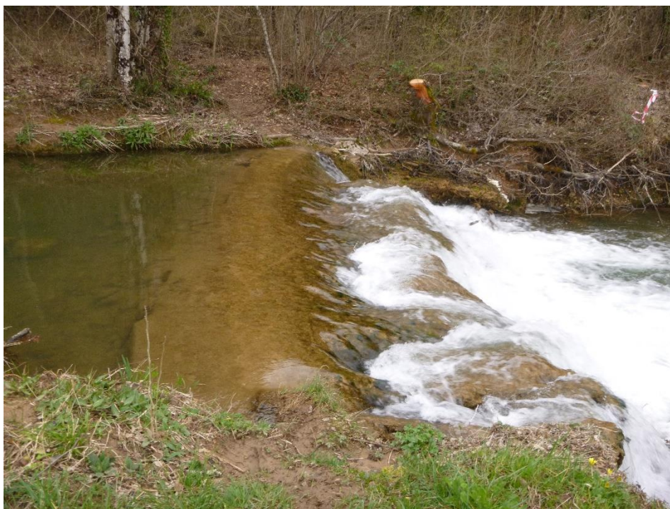
Figure 102 : Etat de comblement du seuil du Pelcourt amont
