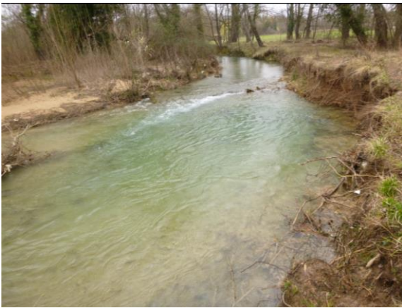
Figure 20 : Berges soumises à l'érosion dans le secteur agricole en aval de Salernes
