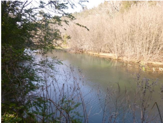
Figure 16 : Berges végétalisées en amont du seuil de Bégon
