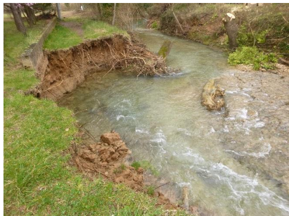
Figure 67 : Erosion de berges en rive gauche environ 100 m en aval du seuil
