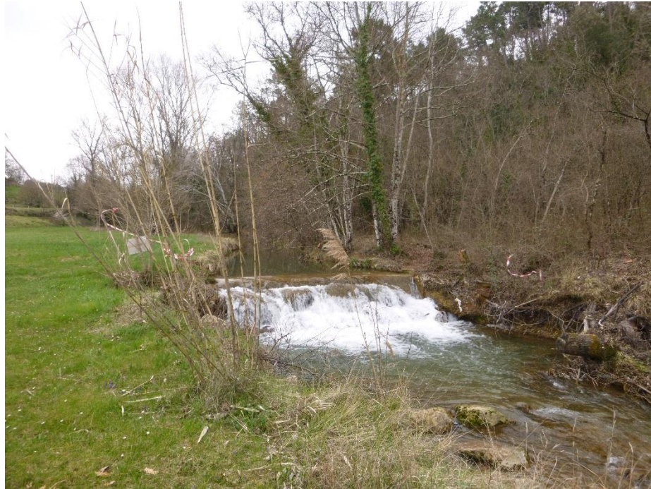
Figure 95 : Seuil du Pelcourt amont
