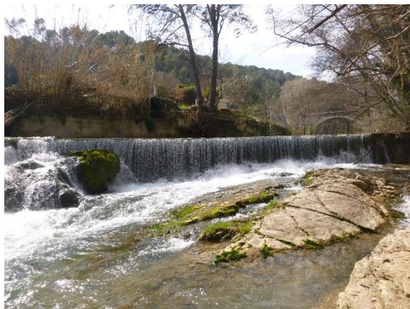
Figure 32 : Affleurement du substratum en aval direct du seuil d'Entrecasteaux
