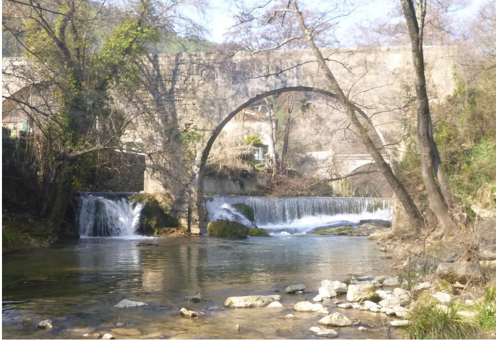
Figure 27 : Seuil d'Entrecasteaux vu depuis l'aval
