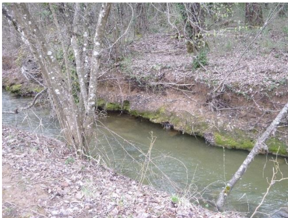
Figure 100 : Plat courant en aval du seuil
