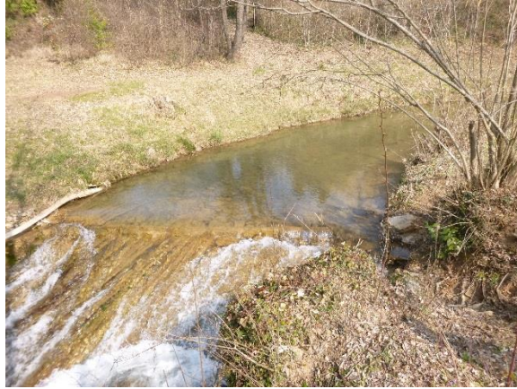
Figure 90 : Ouvrage du Pelcourt aval et plat lentique associé
