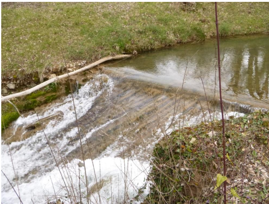
Figure 87 : Seuil du Pelcourt aval vu depuis la rive gauche
