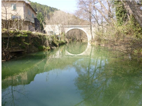
Figure 30 : Zone d'influence en amont du seuil d'Entrecasteaux
