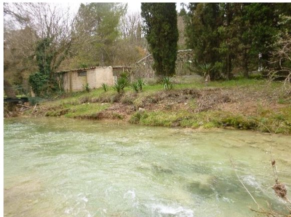
Figure 75 : Erosion de berge en rive droite en aval du seuil
