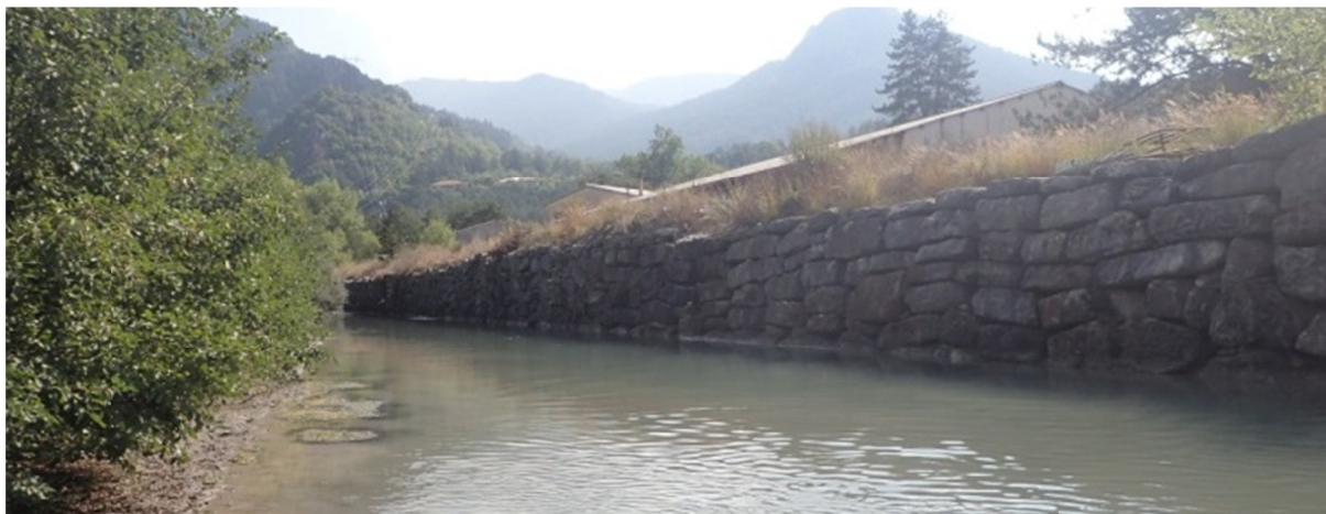
Figure 7 : Mur en enrochement le long de la zone artisanale Source : SIGosphere, 2016
