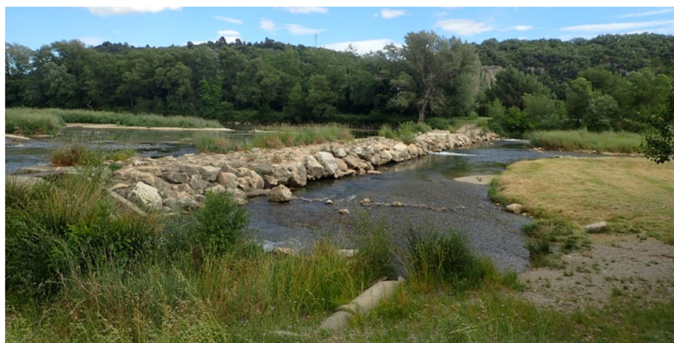
Figure 13 : Seuil en amont de la restitution EDF, sur la commune de Vinon-sur-Verdon Source : SIGosphère, 2016
