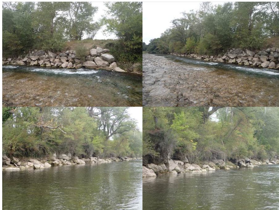
Figure 50 : Photographies de l'enrochement de protection de la station d'épuration de Vinon-sur-Verdon
