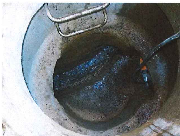
Mesure sur le canal de fuite du DO3
