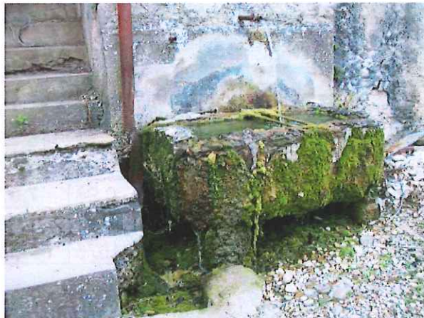
Fontaine en amont du R142
