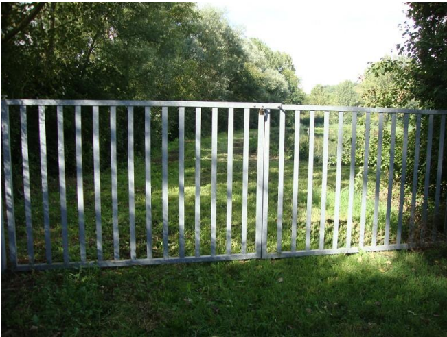
Accès par un portail ; site non clos
