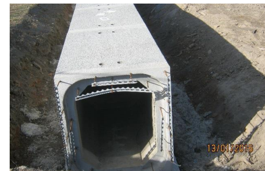
Busage en cours du canal (secteur déviation de Miramas)
