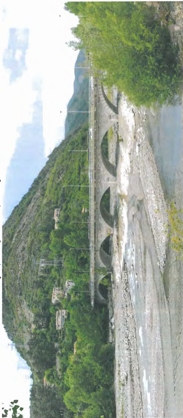
Vue sur le grand pont de Digne-les-Bains depuis la rive gauche en aval de la Bléone
