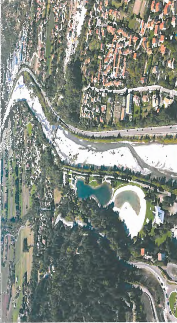
Vue vers l'aval de la Biéone à la hauteur du pont de Nice (crédit photo M. Colin ©)
