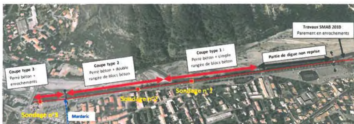
Figure 53 : Localisation des sondages sur la digue des Epinettes aval
