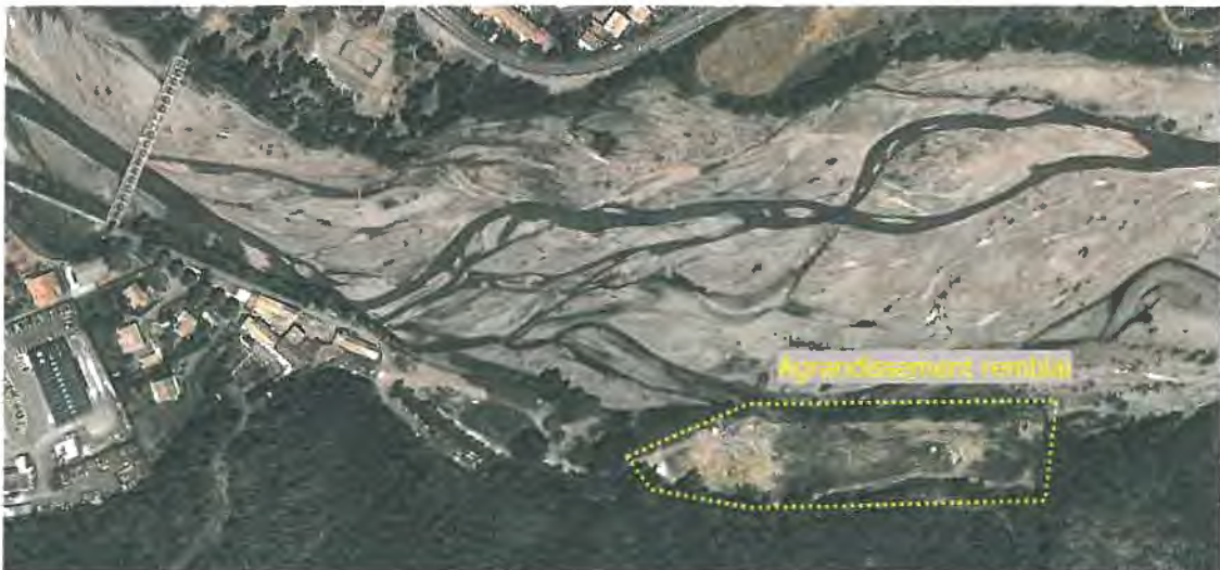
Figure 40 : photo aérienne 2012 (digue des Arches)
