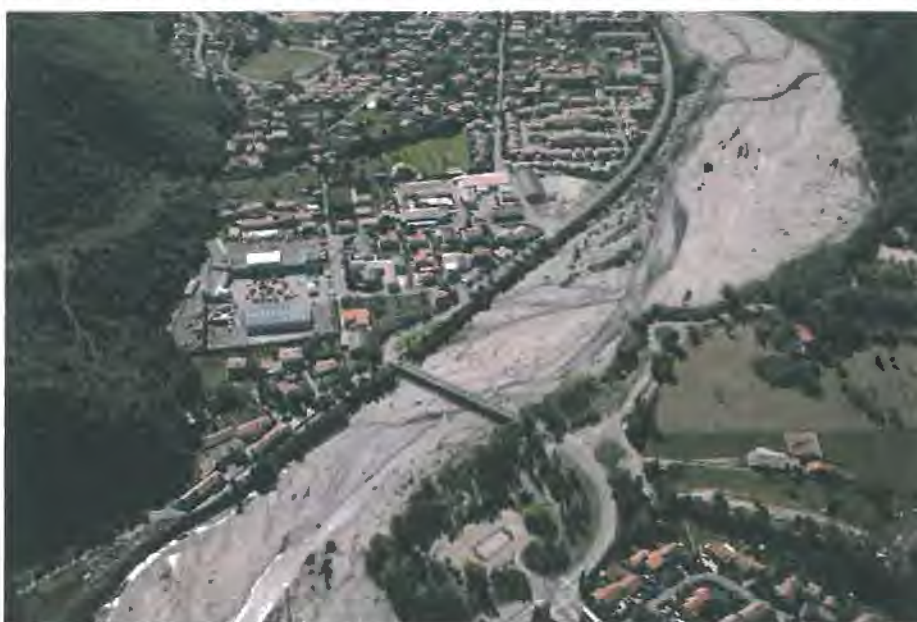
Figure 36 : photo aérienne 2010 (digue des Arches et Epinettes amont)
