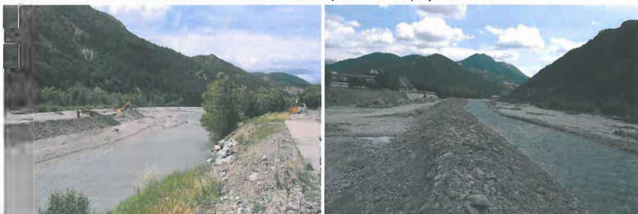
Terrassement et mise en eau d'un chenal de déviation de la Bléone dans le cadre du chantier de confortement de la digue des Epinettes à Digne les Bains (SMAB, 2013)
